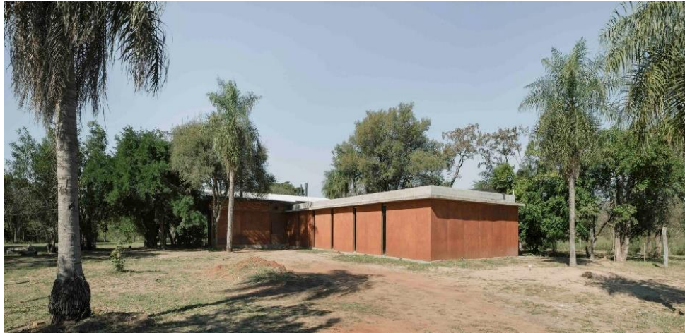
Figura 1. Construcción tradicional en Paraguay
