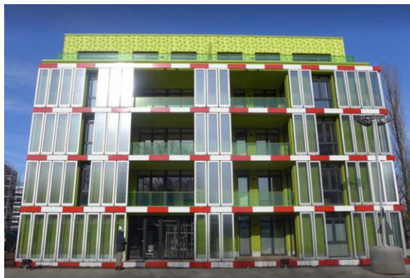
Figura 19. Fachada casa de las algas
