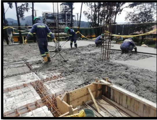
Imagen 10: Fundición de placa de entrepiso.
