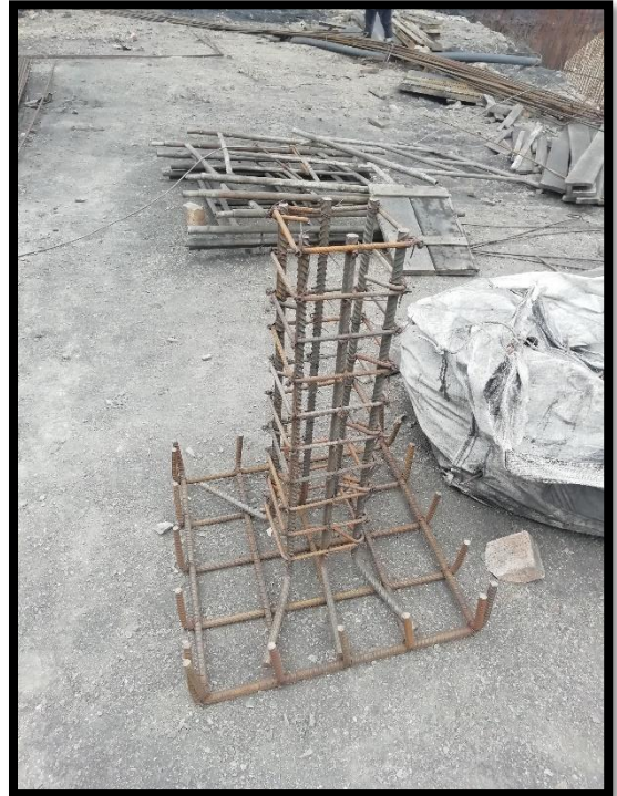
Imagen 23: Canastas de acero pedestales DCL.
