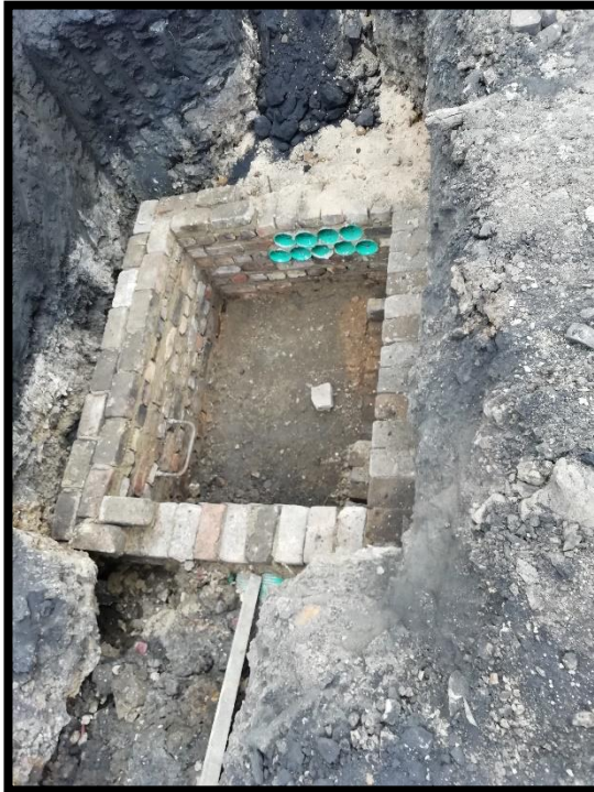
Imagen 20: Instalación de mampostería para caja de inspección DCL.
