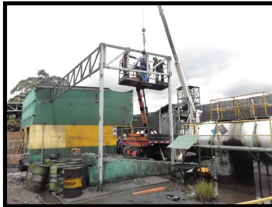
Imagen 33: Desmante de estructura metálica.
