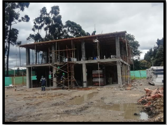
Imagen 11: Estructura en concreto de las nuevas oficinas administrativas.
