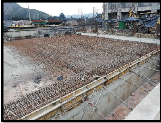
Imagen 3: Armado de parrilla de acero y vigas transversales de placa de hornos.
