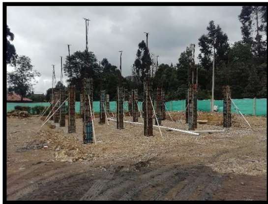
Imagen 43: Estado inicial de las obras en las oficinas administrativas.
