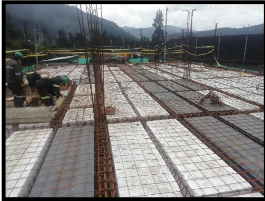
Imagen 12: Amarre de acero para placa de entrepiso.
