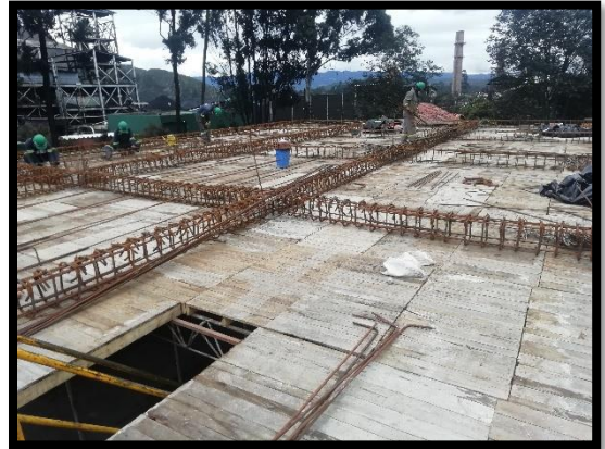
Imagen 13: Amarre de acero para vigas de cubierta
