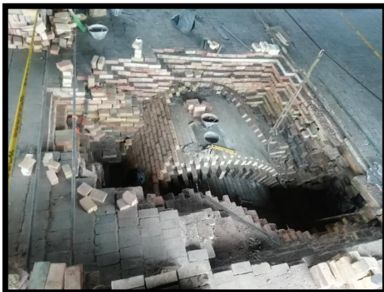
Imagen 24: Instalación de cuña para cúpula horno 30, Batería 2B.
