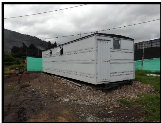
Imagen 35: Contenedor de baños para uso de contratistas.
