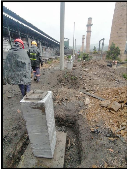
Imagen 46: Línea de pedestales para soportes de blindobarra.
