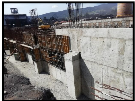
Imagen 6: Fundición de sección del ducto WHT.
