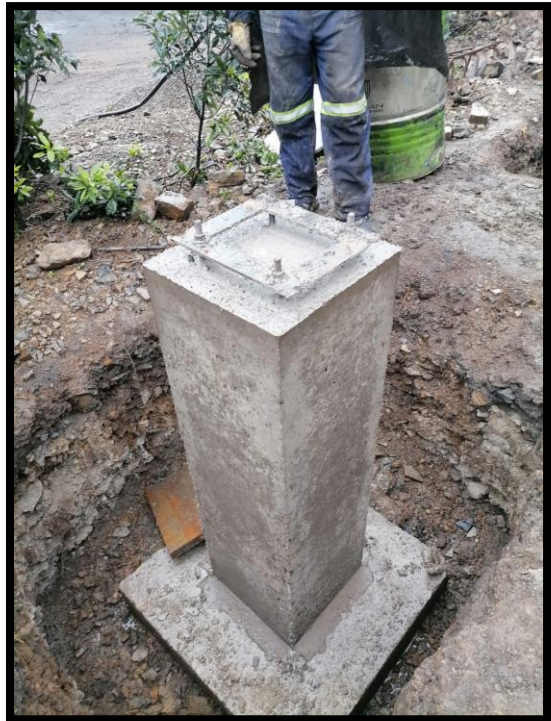
Imagen 47: Ejemplo pedestal terminado para DCL.
