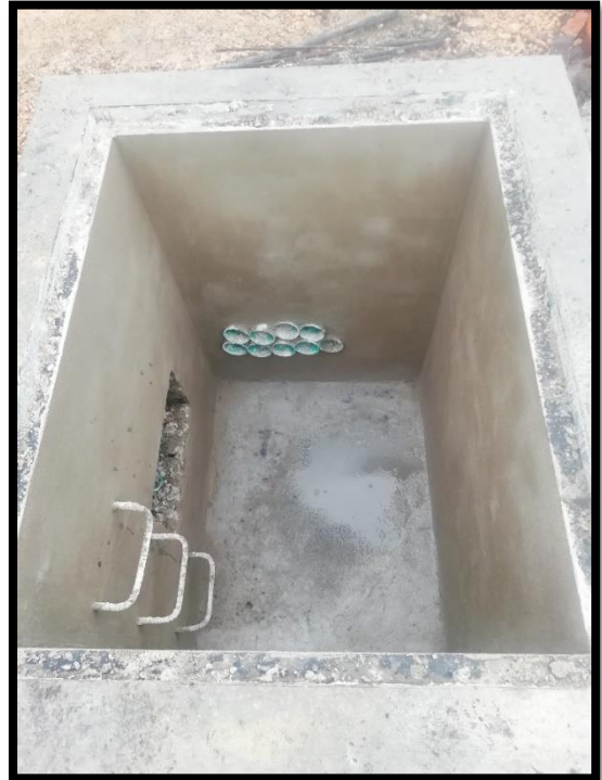
Imagen 21: Caja de inspección DCL terminada.
