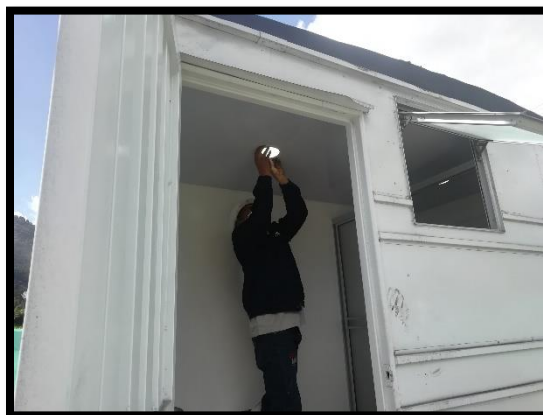
Imagen 36: Reparaciones realizadas por el contratista AVANTI.
