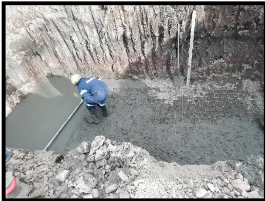
Imagen 28: Instalación solado de limpieza y nivelación para sistema séptico.
