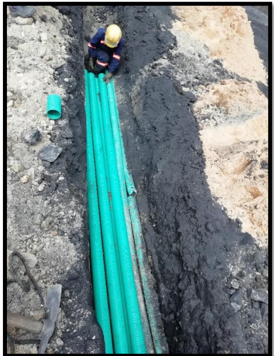
Imagen 19: Instalación de tubería PVC CONDUIT.
