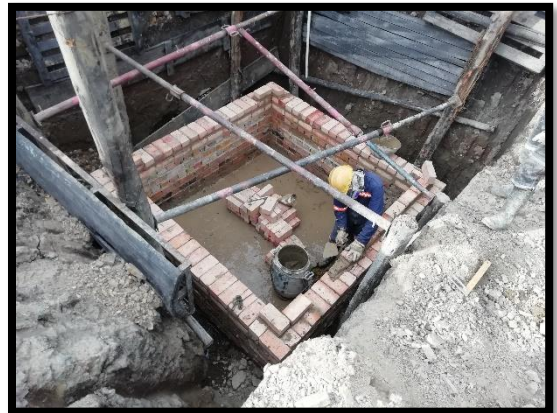
Imagen 29: Instalación de mampostería en saga y tizón para sistema séptico.
