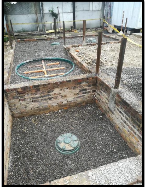
Imagen 31: Sistema séptico terminado.
