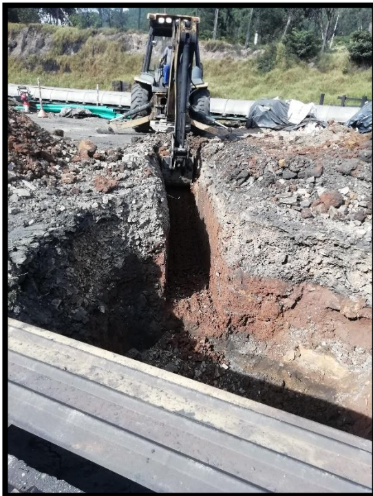
Imagen 18: Excavación línea DCL con retroexcavadora 430F.
