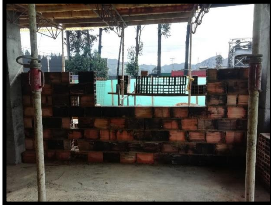
Imagen 14: Instalación de muros perimetrales de mampostería.
