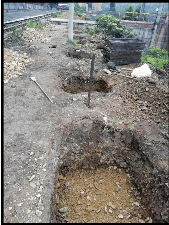
Imagen 22: Excavaciones para pedestales DCL.
