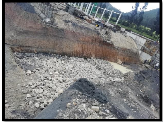
Imagen 2: Mejoramiento del suelo para ducto Main Tunnel con rajón.
