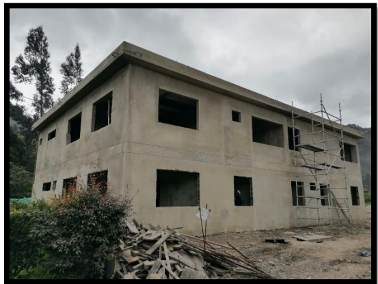
Imagen 44: Estado final de las obras en las oficinas administrativas.
