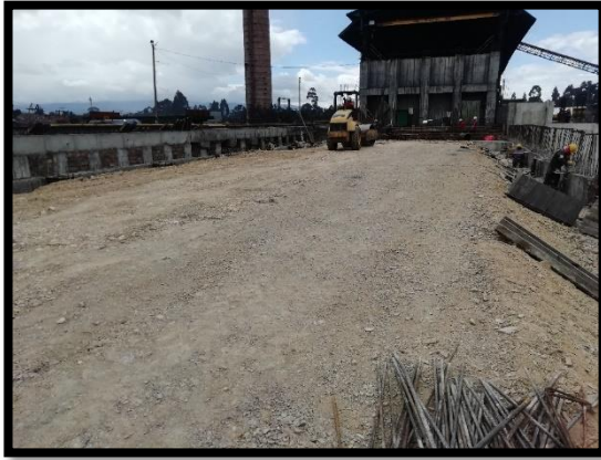
Imagen 1: Compactación con Vibrocompactador.
