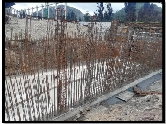
Imagen 4: Amarre de acero para muros del ducto Main Tunnel.
