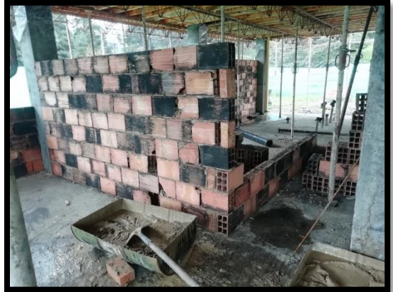
Imagen 15: Instalación de muros internos de mampostería.
