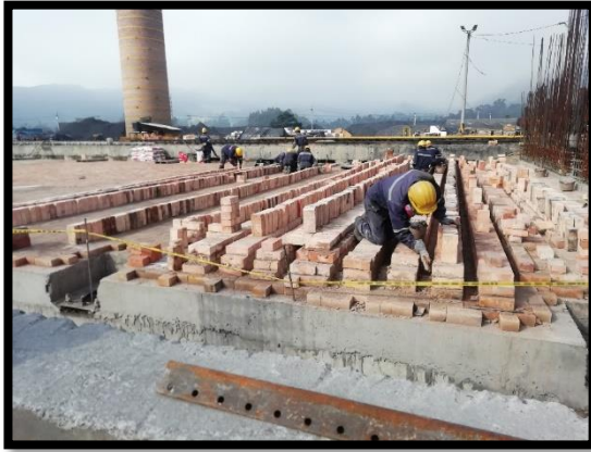
Imagen 7: Instalación de la hilada 4 de mampostería para placa de hornos.
