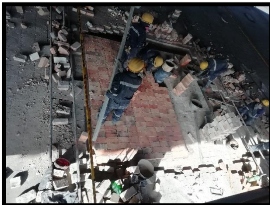
Imagen 25: Instalación de relleno de cúpula Horno 30, Batería 2B.
