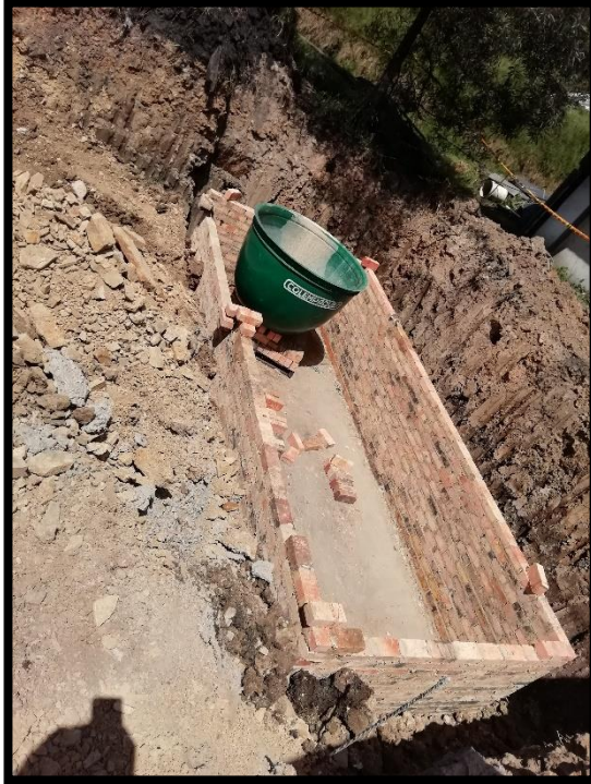
Imagen 30: Instalación de mampostería para tanque séptico y anaeróbico.
