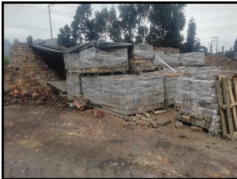
Imagen 40: Recuperación de mampostería.
