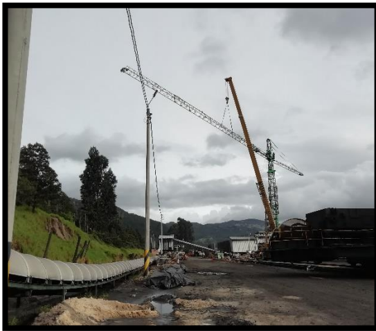
Imagen 8: Ensamblado de torre grúa.
