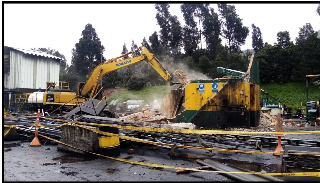
Imagen 34: Demolición cuarto de taller de mantenimiento.
