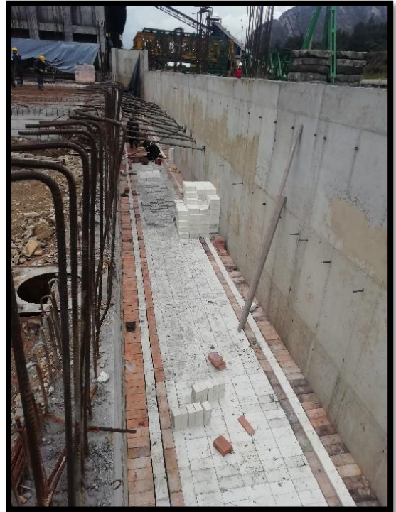
Imagen 9: Instalación de mampostería aislante en ducto WHT.
