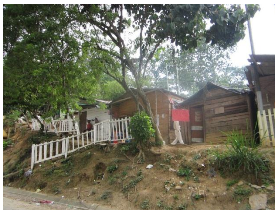
Gaviones utilizados por la comunidad para ser utilizados como soporte para la vivienda.
