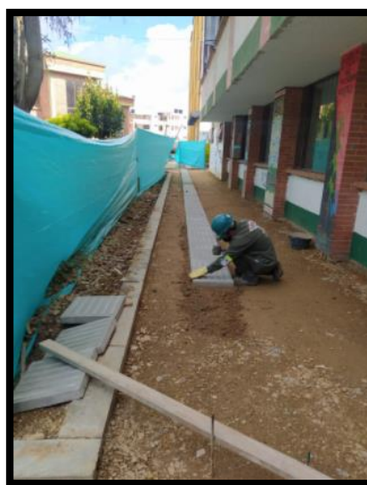
Figura 24. Instalación loseta
