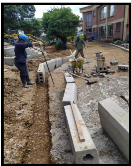
Figura 25. Instalación de bordillos sardinel.
