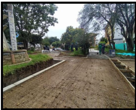
Figura 33. Instalación de malla electrosoldada.
