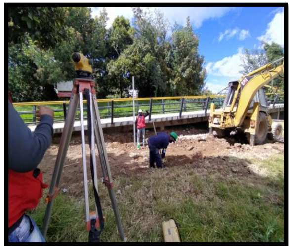
Figura 13. supervisión volúmenes de excavación.
