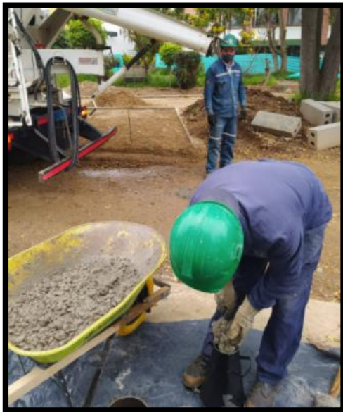
Figura 39. Toma de asentamiento.
