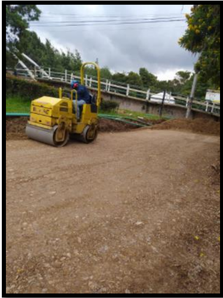
Figura 31. Compactación Subbase.
