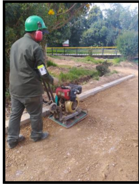
Figura 30. Compactación Subbase.
