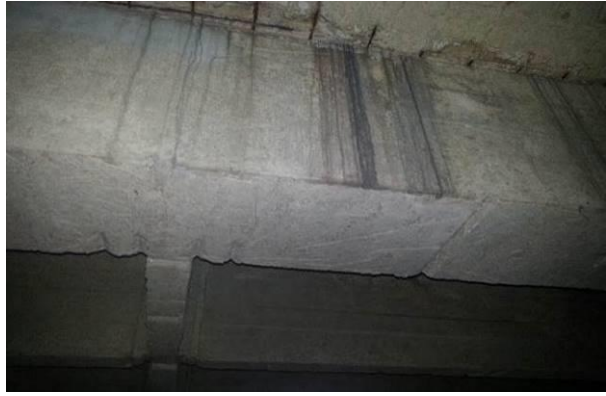
Fig.#82 Filtración por la unión entre tubería de desagüe y concreto de la losa. se aprecian marcas de agua en vigas producto de filtraciones
