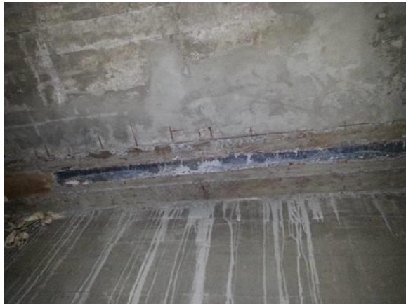
Fig.#70 Muros deteriorados por el accionar de las aguas de nivel freático y flujo del agua por entre las losetas del entrepiso
