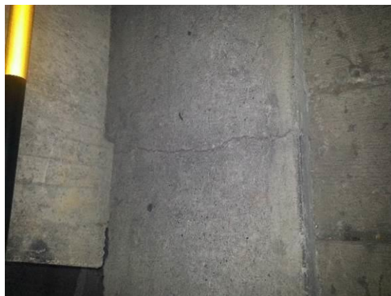
Fig. # 31 Se apreciaron fisuras en la rampa de tránsito en la zona de los andenes ocasionada por la falta de juntas de dilatación
