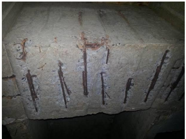
Fig.#83 Estribos de vigas sin recubrimiento se exponen a la intemperie presentando oxidación. El refuerzo a flexión también se encuentra afectado
