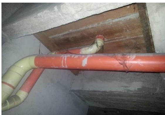
Fig.# 72 Ausencia de cintas de anclaje para la tubería de desagüe
