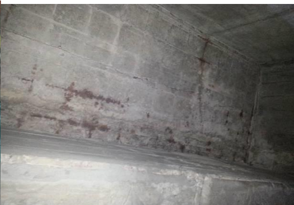
Fig.#70 Muros deteriorados por el accionar de las aguas de nivel freático y flujo del agua por entre las losetas del entrepiso
