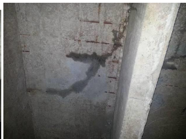
Fig. #84 Malla electro soldada superficial que presento oxidación
