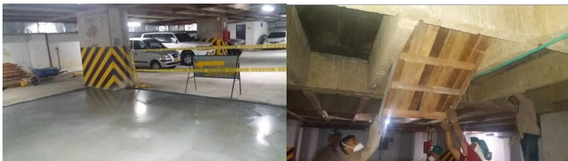
Fig. #121 Curado y desencofre
