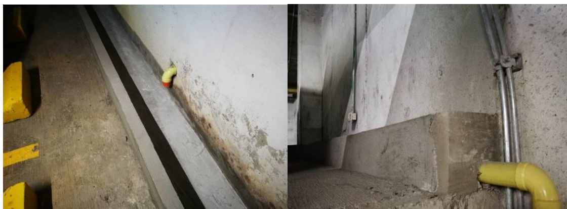
Fig. #130 construcción canaletas perimetrales
