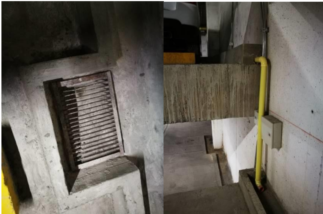
Fig. #129 construcción de sifones nuevos
