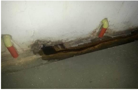
Fig.#82 Filtración por la unión entre tubería de desagüe y concreto de la losa. se aprecian marcas de agua en vigas producto de filtraciones
