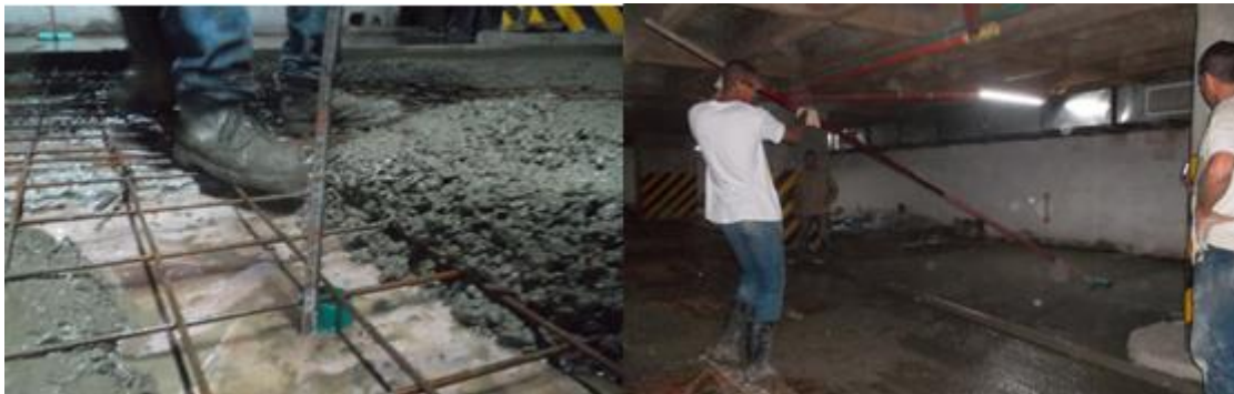
Fig. #120 Fundición de Obra
