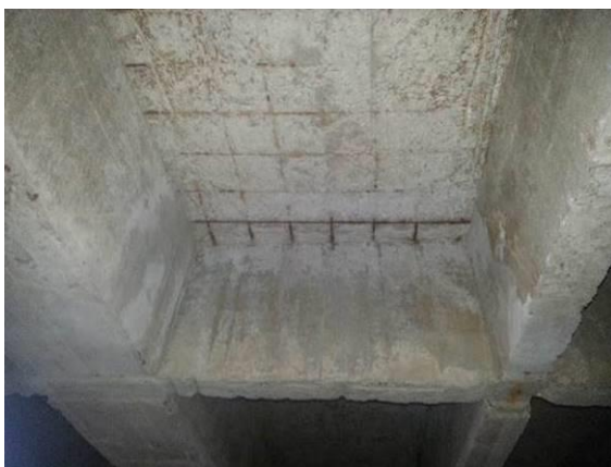
Fig. #84 Malla electro soldada superficial que presento oxidación
