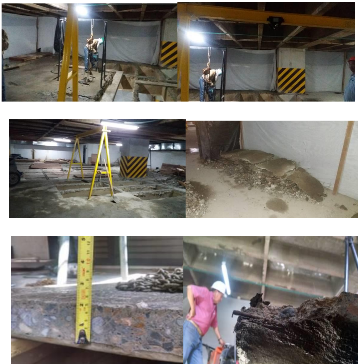
Fig. #116 Demolición losetas de entrepiso
