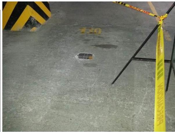
Fig. # 30 Agrietamiento y Deterioro de las losetas de la losa de entepiso
