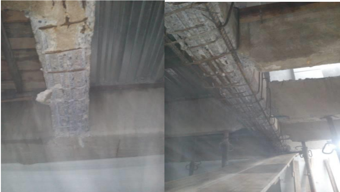
Fig. #125 Encamisado de vigas
