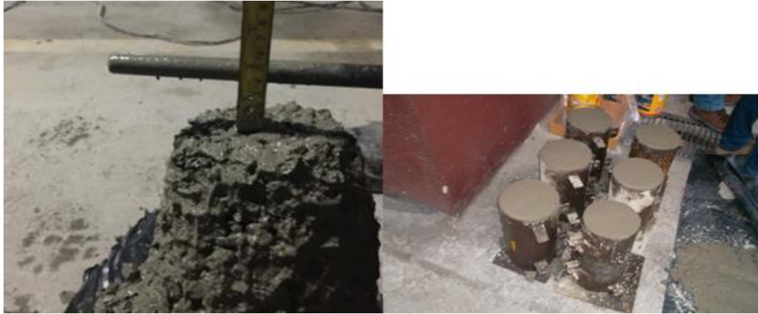
Fig. #119 Control de calidad del concreto
