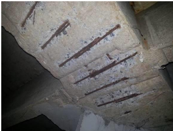
Fig.#83 Estribos de vigas sin recubrimiento se exponen a la intemperie presentando oxidación. El refuerzo a flexión también se encuentra afectado
