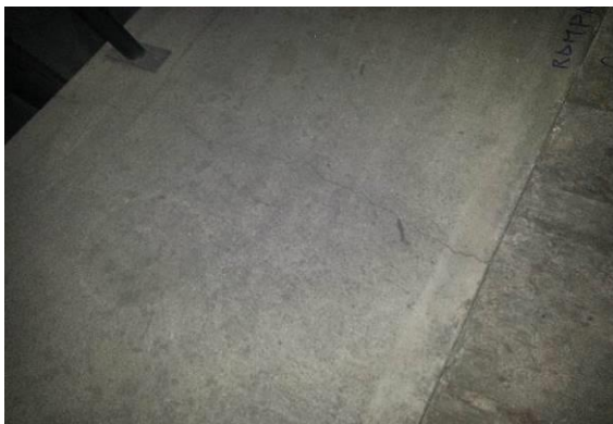
Fig. # 31 Se apreciaron fisuras en la rampa de tránsito en la zona de los andenes ocasionada por la falta de juntas de dilatación
