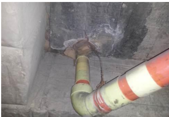
Fig.# 72 Ausencia de cintas de anclaje para la tubería de desagüe
