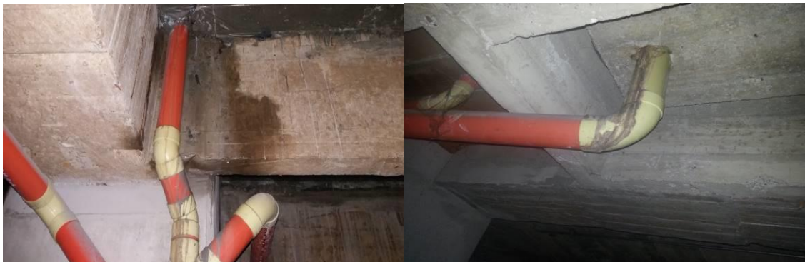
Fig. #128 humedades por fallas en los empates de los desagües
