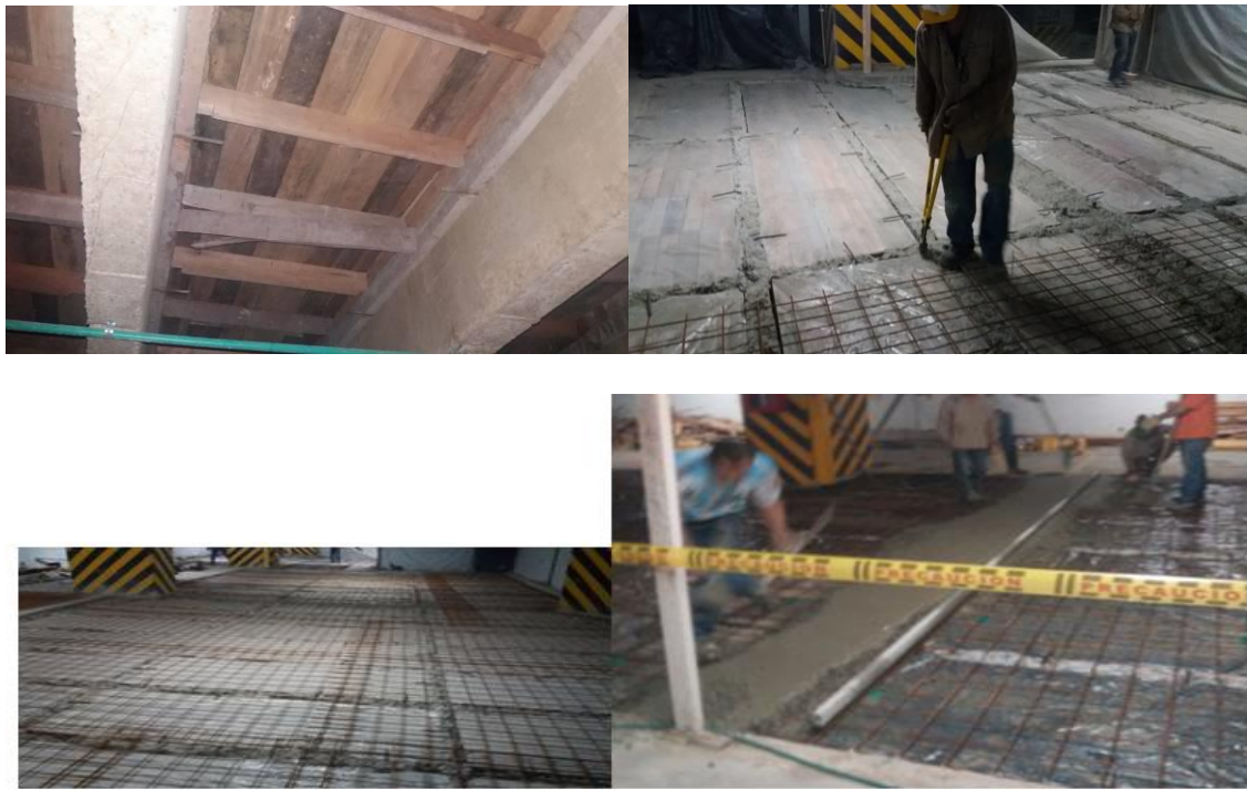
Fig. #117 Encofrado y armado
