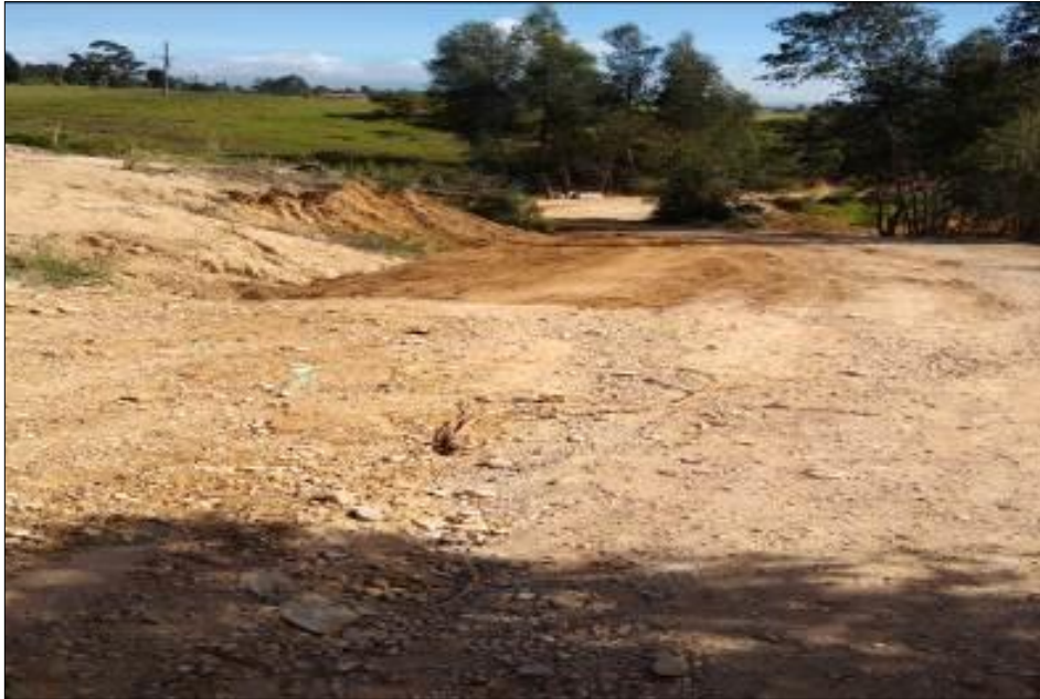
Figura 4. Estado del tramo 2 antes de su intervención-Vereda San Martín.
