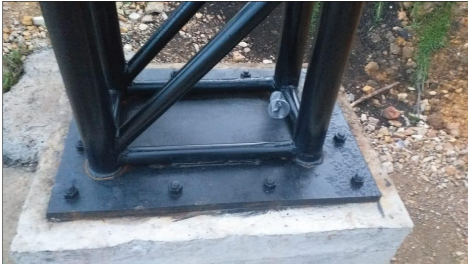
Figura 14. Detalle de conexión a la cimentación superficial.
