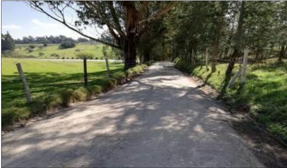
Figura 5. Estado del tramo 3 antes de su intervención-Vereda San Martín
