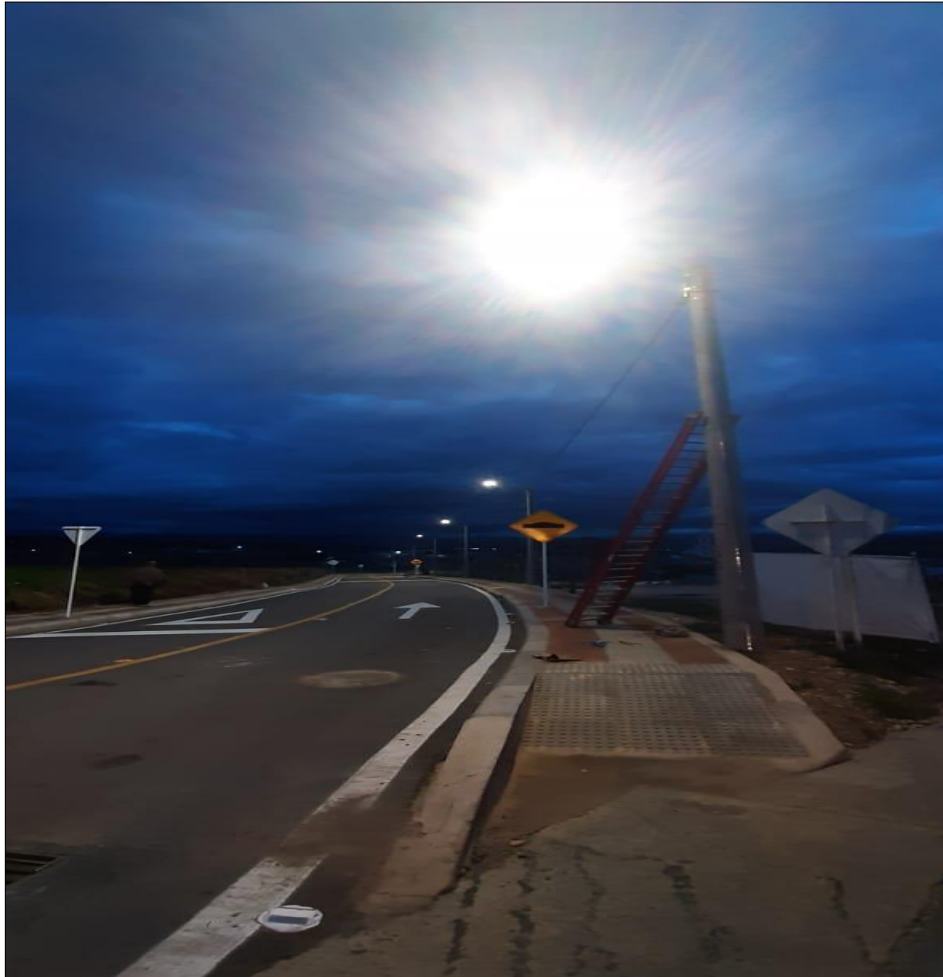
Figura 23. finalización de la obra.
