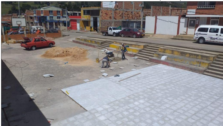
Figura 9. Instalación de baldosa costado occidental del polideportivo municipal.
