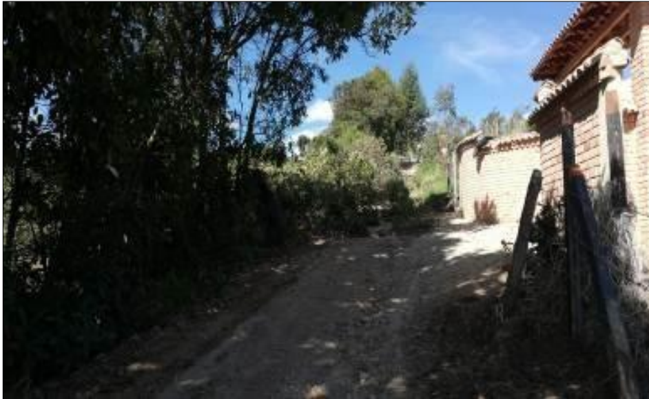
Figura 3. Estado del tramo 1 antes de su intervención-Vereda San Francisco.
