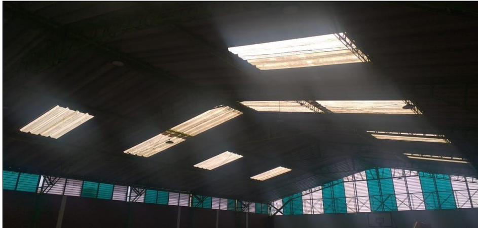
Figura 8. Cubierta antigua polideportivo municipal.
