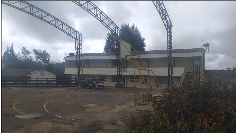
Figura 15. Instalación de cerchas metálicas.
