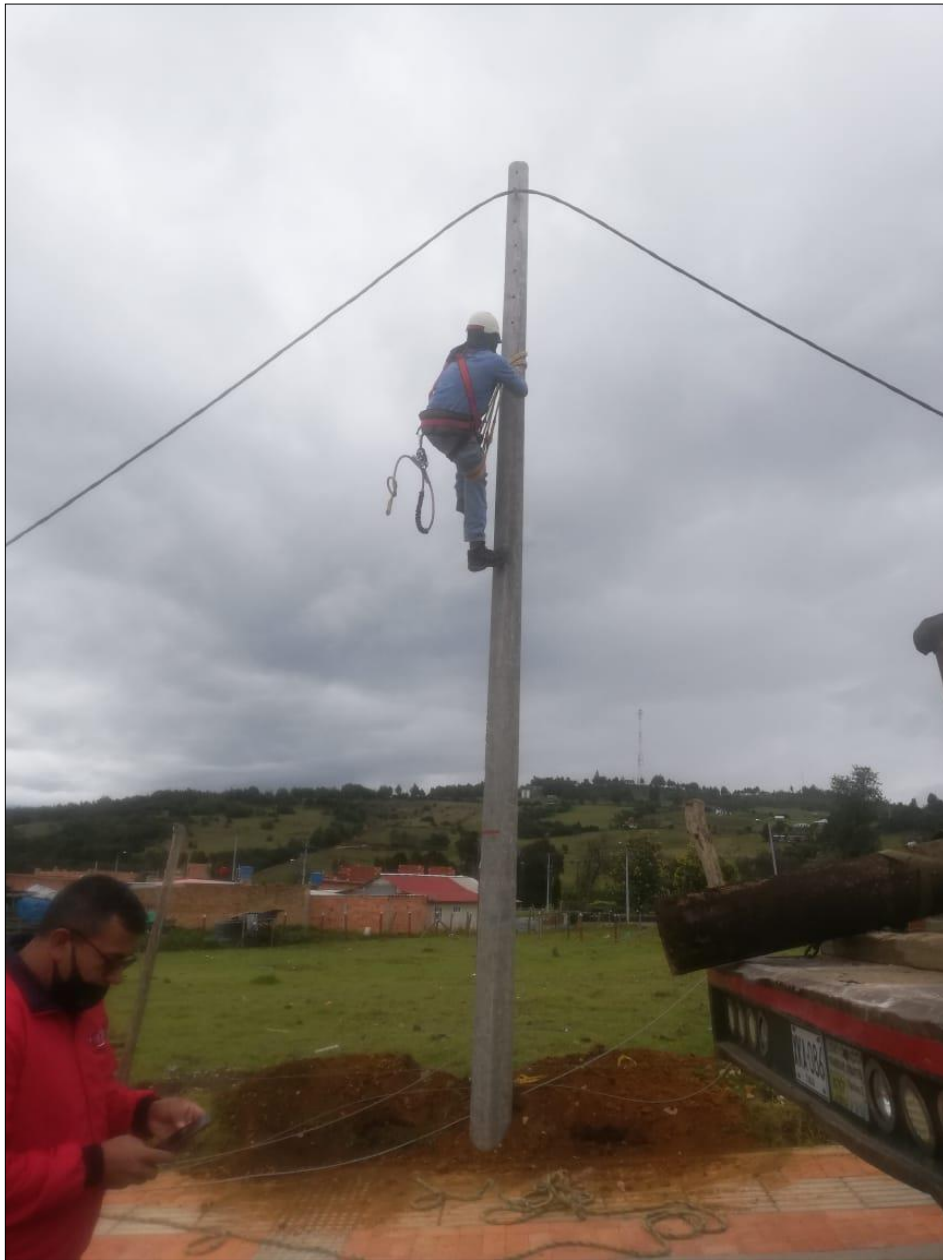
Figura 21. Instalación de postes en hormigón.
