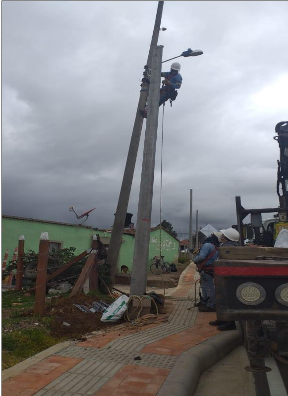
Figura 22. Instalación de luminaria.
