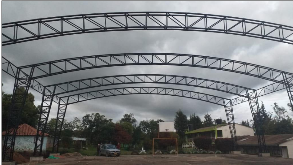
Figura 16. Unión con soldadura de la cubierta.
