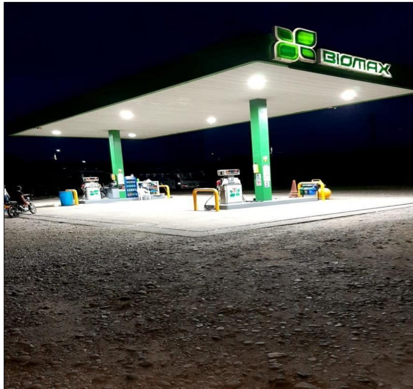
Figura 2. Instalación nocturna EDS San Lorenzo
