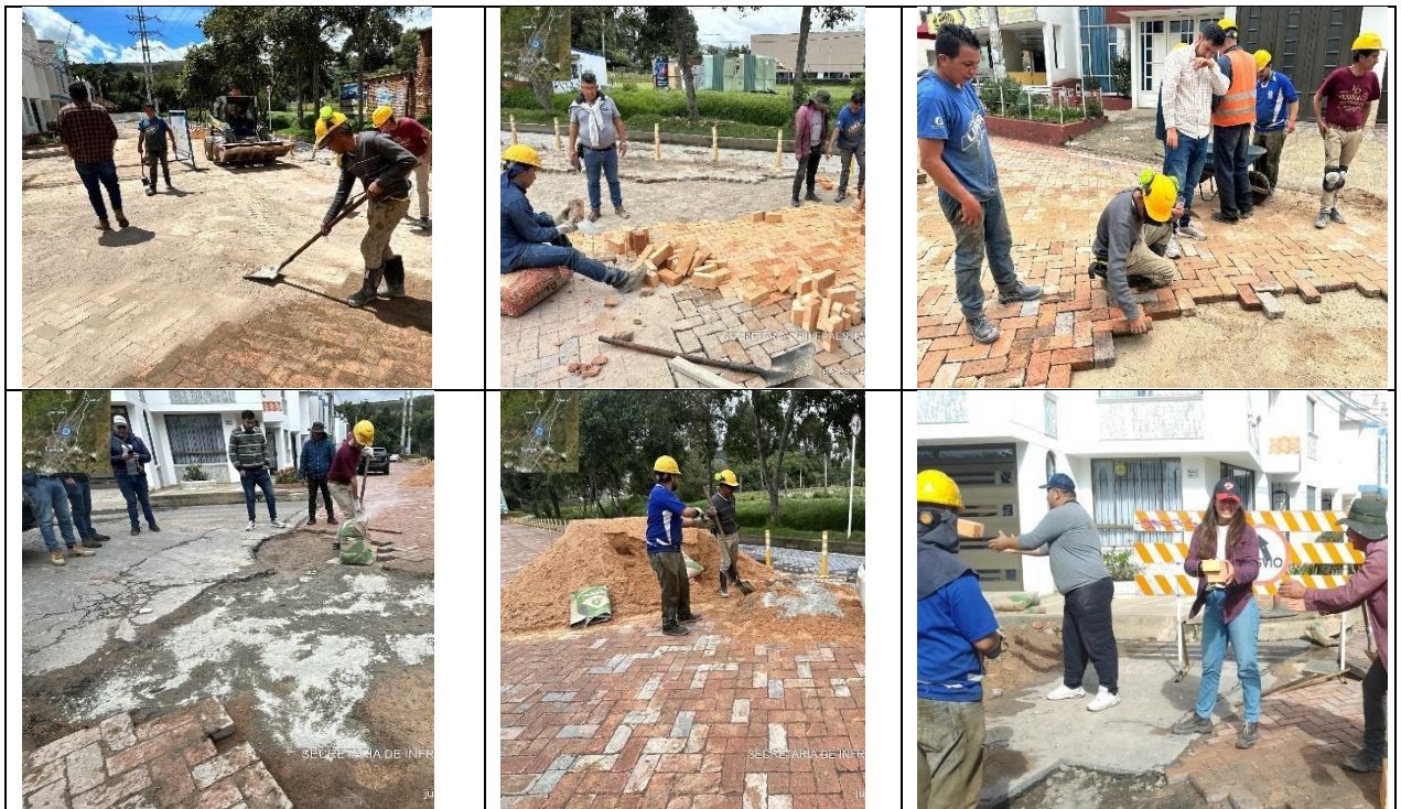
Ilustración 21. Seguimiento en campo para la rehabilitación del adoquín barrio las Quintas.
