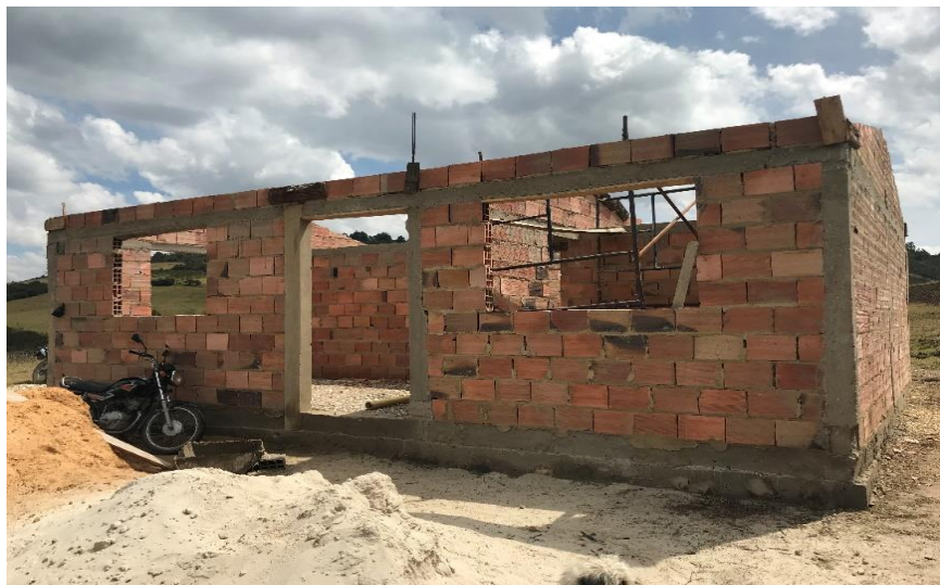
Ilustración 7. Fachada de la vivienda.
