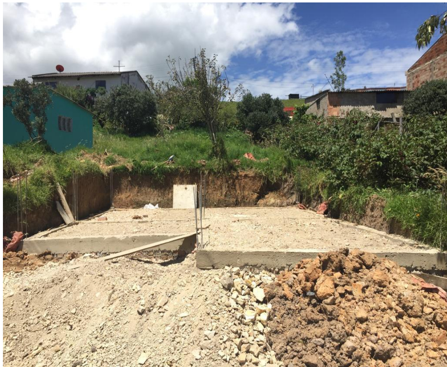
Ilustración 9. Cimentación de la vivienda
