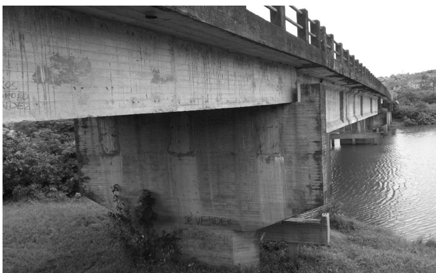
Figura 10. Vista lateral de la superestructura.
