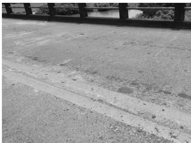
Figura 14. Detalle superficie del tablero.
