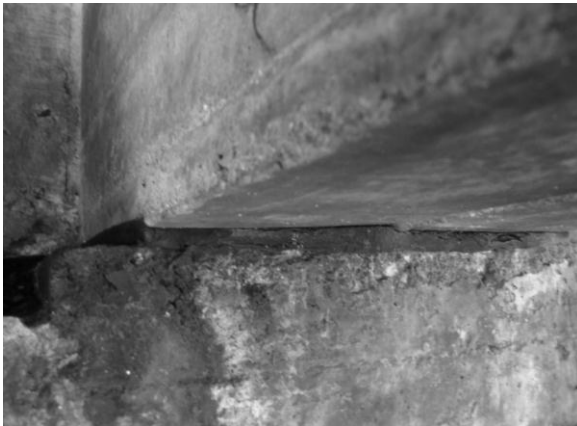
Figura 26. Neoprenos bajo vigas.
