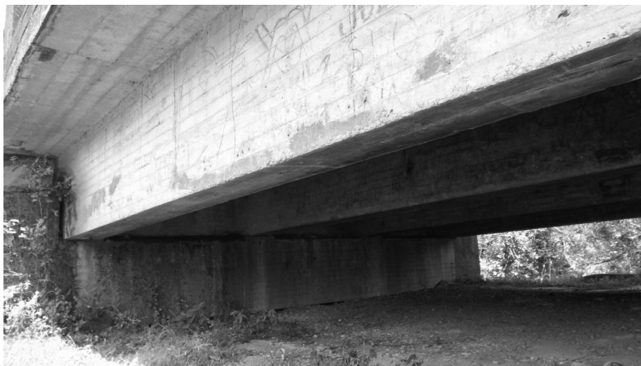
Figura 12. Vista del estribo costado Puerto López.
