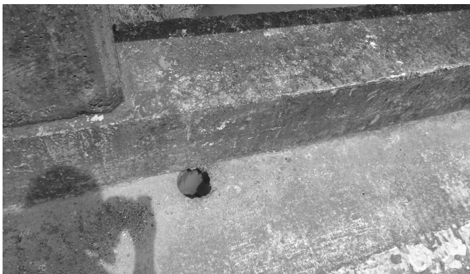
Figura 15. Detalle del bordillo y drenaje.
