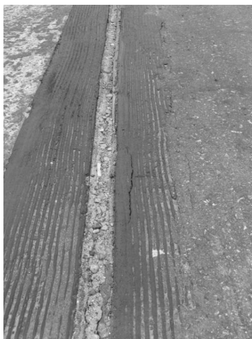
Figura 20. Detalle del dispositivo de junta de dilatación.
