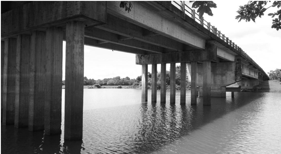
Figura 11. Vista general de la infraestructura.
