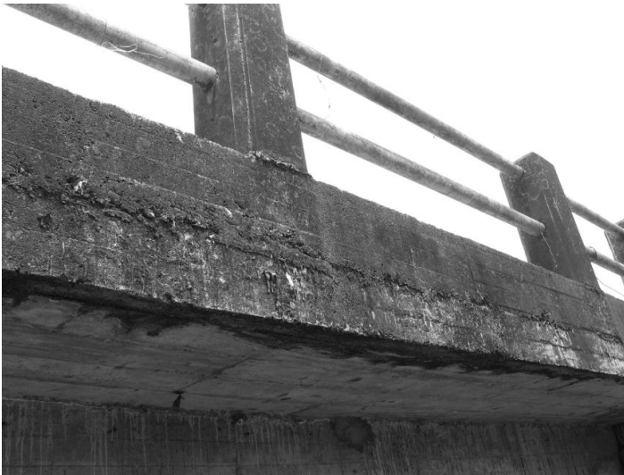
Figura 17. Estado actual de las barandas vista externa.
