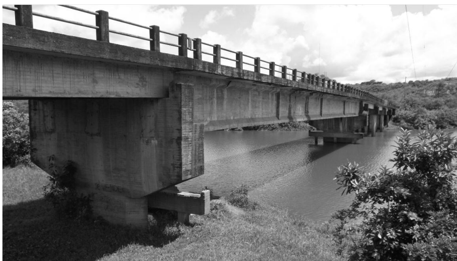
Figura 2. Vista general del puente.
