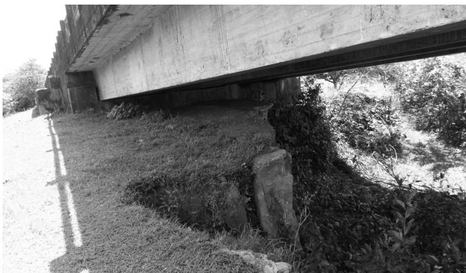
Figura 13. Vista del estribo costado Puerto Gaitán.
