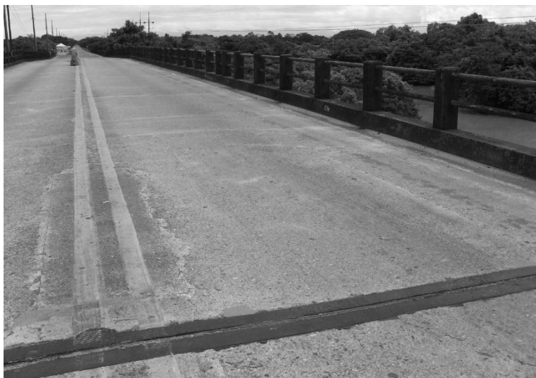
Figura 9. Vista general de la superficie del puente.
