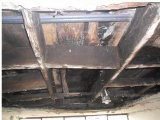
Fotografía 4. Filtraciones desde la cubierta Fuente: Propia
