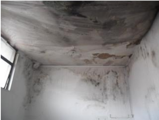
Fotografía 5. Afectación de la humedad en la edificación Fuente: Propia
