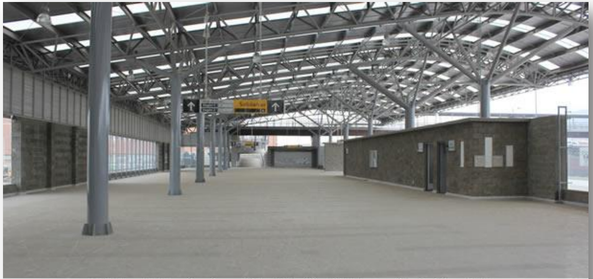
Totalmente terminada está la Estación de Integración de San Mateo
