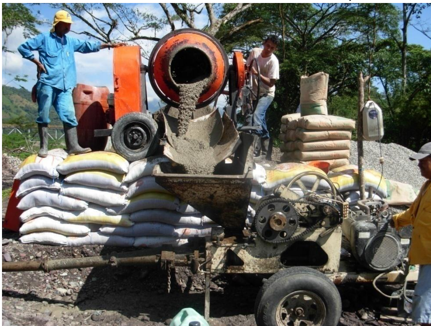
Proceso de Relleno de un Bolsacreto.
