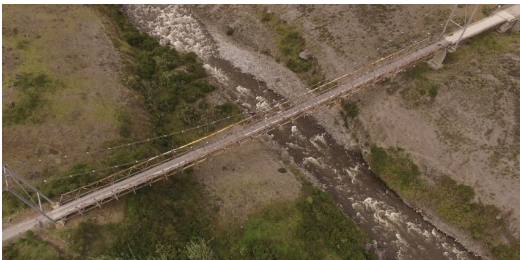
Figura 11. Vista aérea del puente vano central. Fuente propia.
