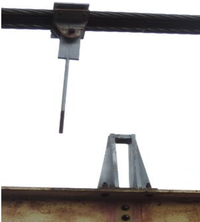
Figura 43. Pendolón desconectado. Fuente propia
