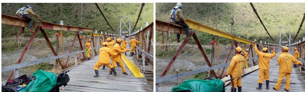
Figura 8. Cambio de sección de viga superior del puente. Fuente JOYCO SAS
