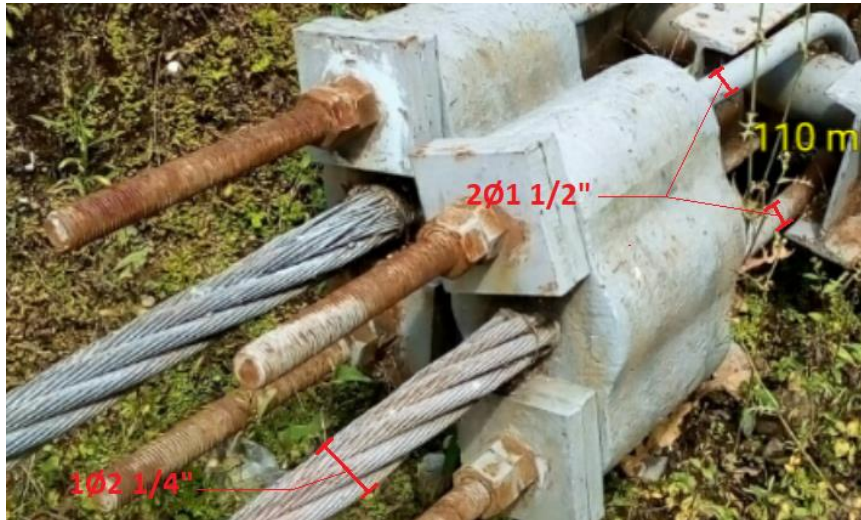
Figura 20. Anclaje cables de \varnothing 2 \frac{1}{4} "
