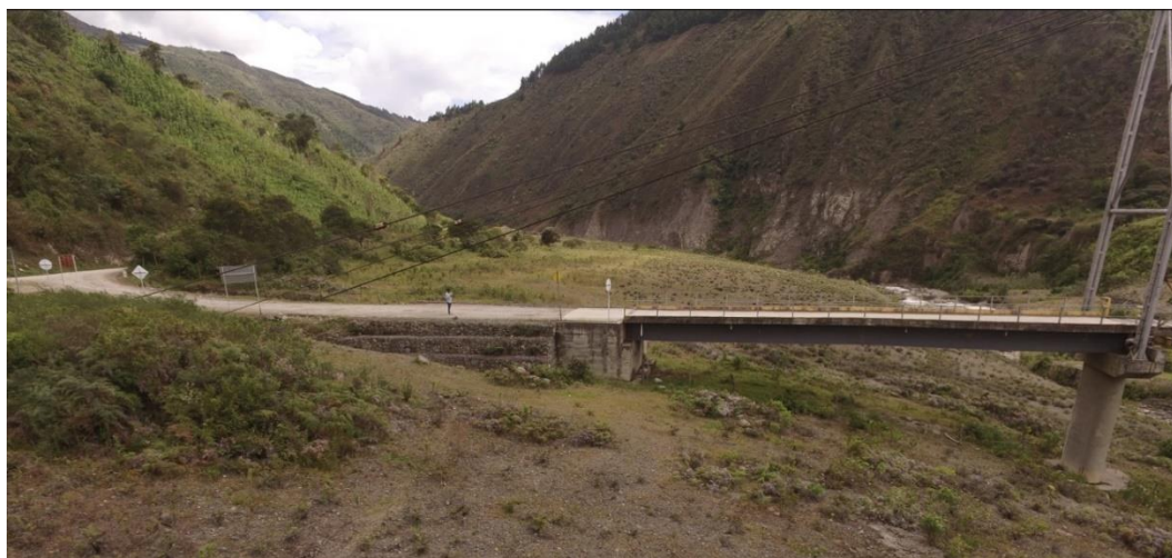
Figura 12. Aproche sur occidental del puente. Fuente propia.
