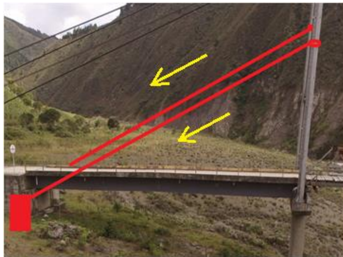
Figura 71. Instalación de tensores auxiliares (Elaboración propia)
