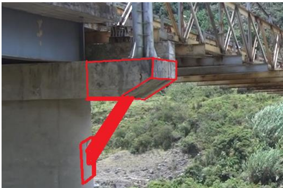
Figura 70. Refuerzo viga cabezal
