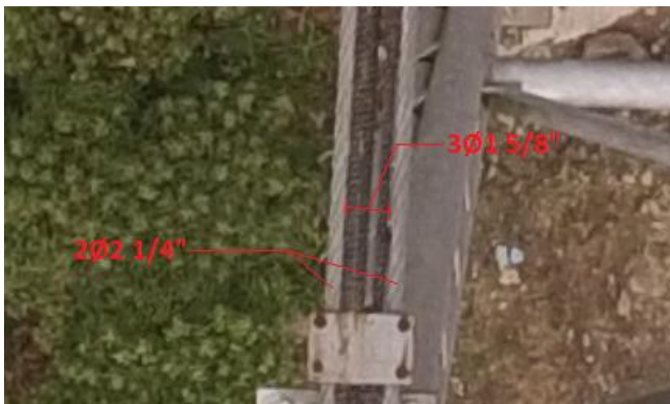
Figura 14. Vista aérea grapo de cables cable principal. Fuente propia.
