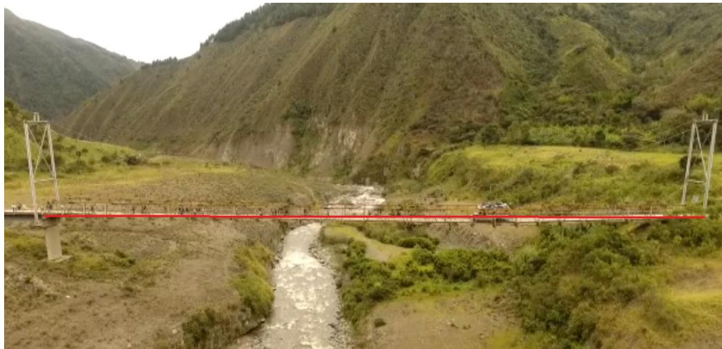
Figura 86. Contra flecha del puente
