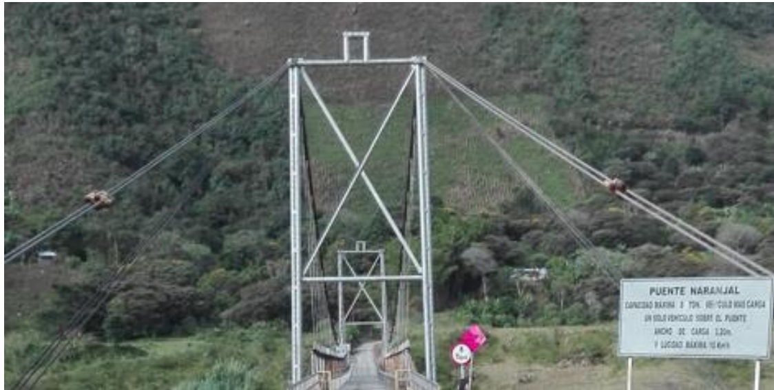
Figura 16. Torre del puente. Fuente propia.
