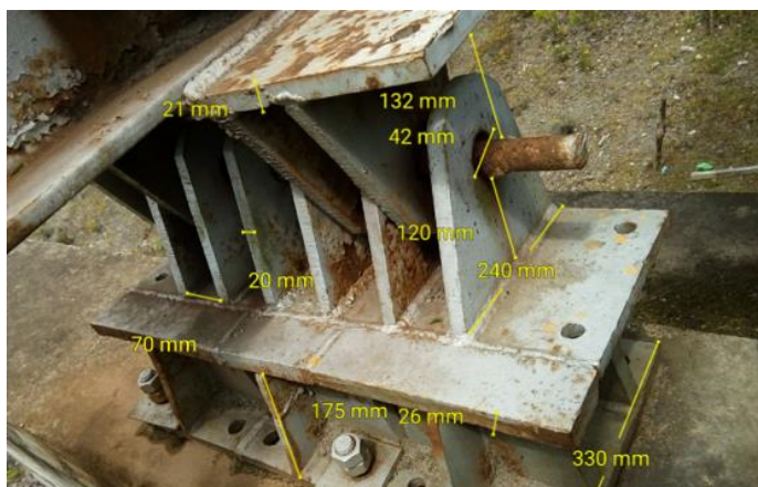
Figura 34. Geometría apoyo fijo
