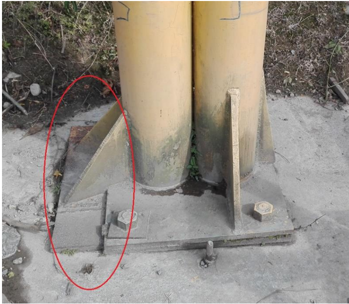
Figura 4. Extensión de la placa base Fuente propia
