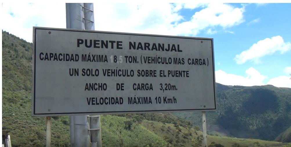
Figura 9. Aviso a la entrada del puente. fuente propia
