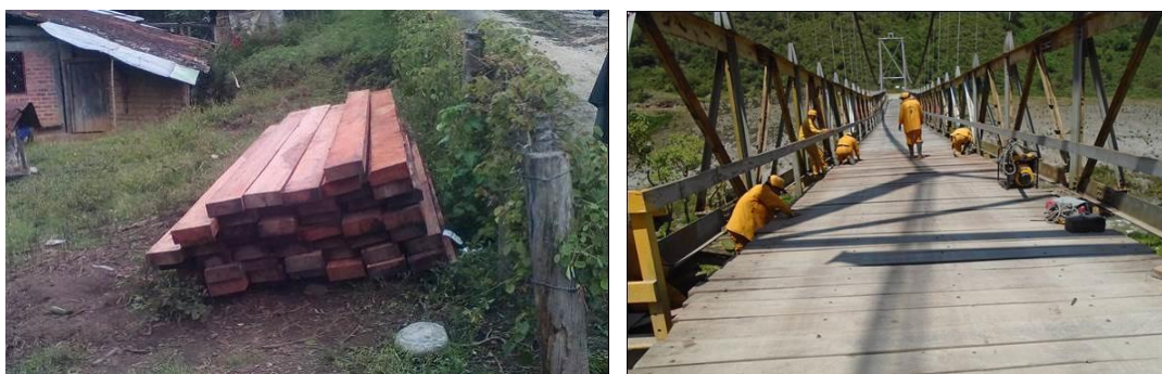
Figura 72. Montaje tablero del puente. (Archivo Joyco S.A.S.)
