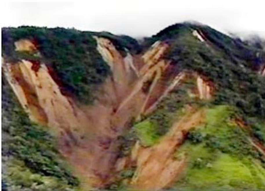
Figura 56. Zona de deslizamiento Páez. Foto Proclama 1994
