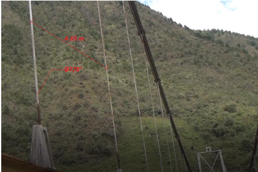
Figura 26. Detalle separación de pendolones
