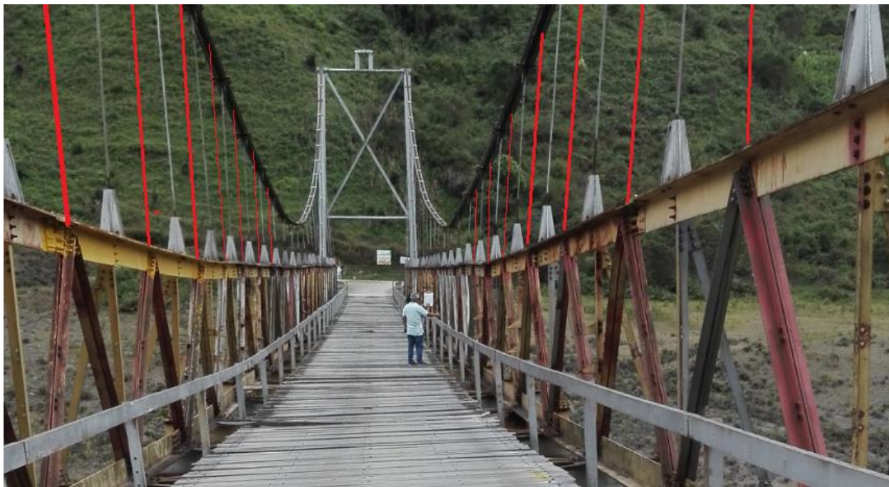
Figura 81. Colocación pendolones intermedios
