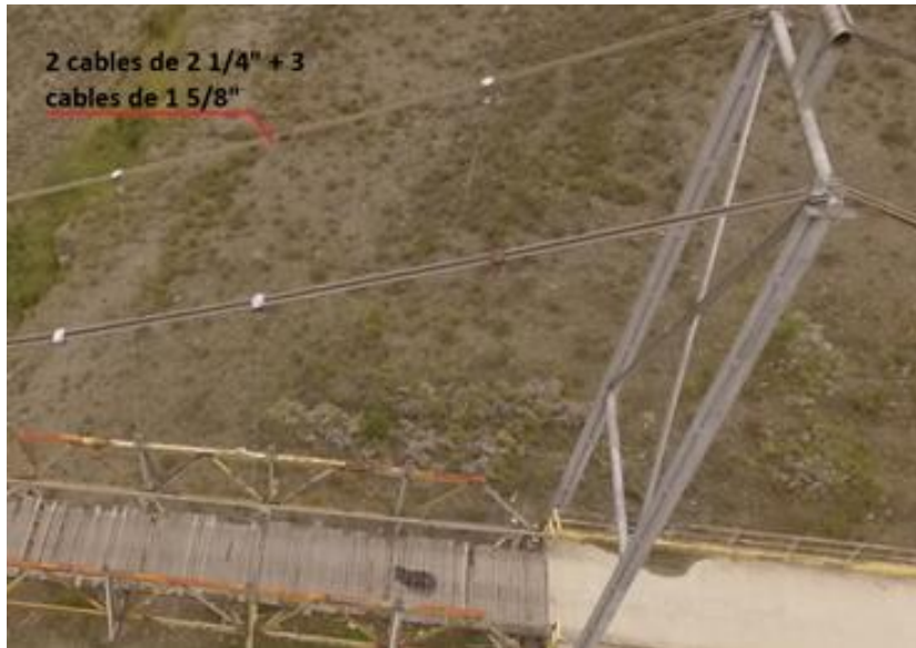
Figura 13. Descripción cable principal. Fuente propia.
