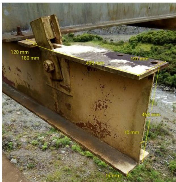
Figura 37. Viga traviesa. Elaboración propia.
