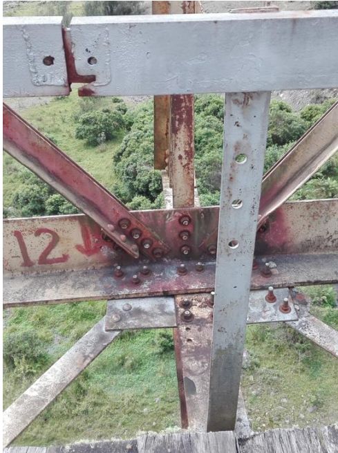
Figura 30. Empalme Baranda. Fuente propia.
