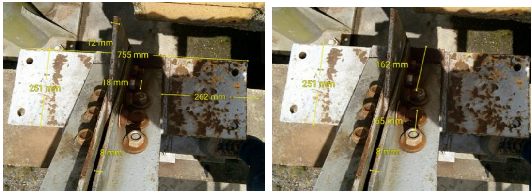
Figura 32. Inicio viga de rigidez cordón inferior. Elaboración propia.
