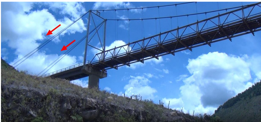
Figura 87. Tensionamiento de cables principales (Fuente propia)
