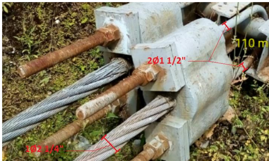
Figura 73. Anclaje cables principales 2Ø 2 1/4"
