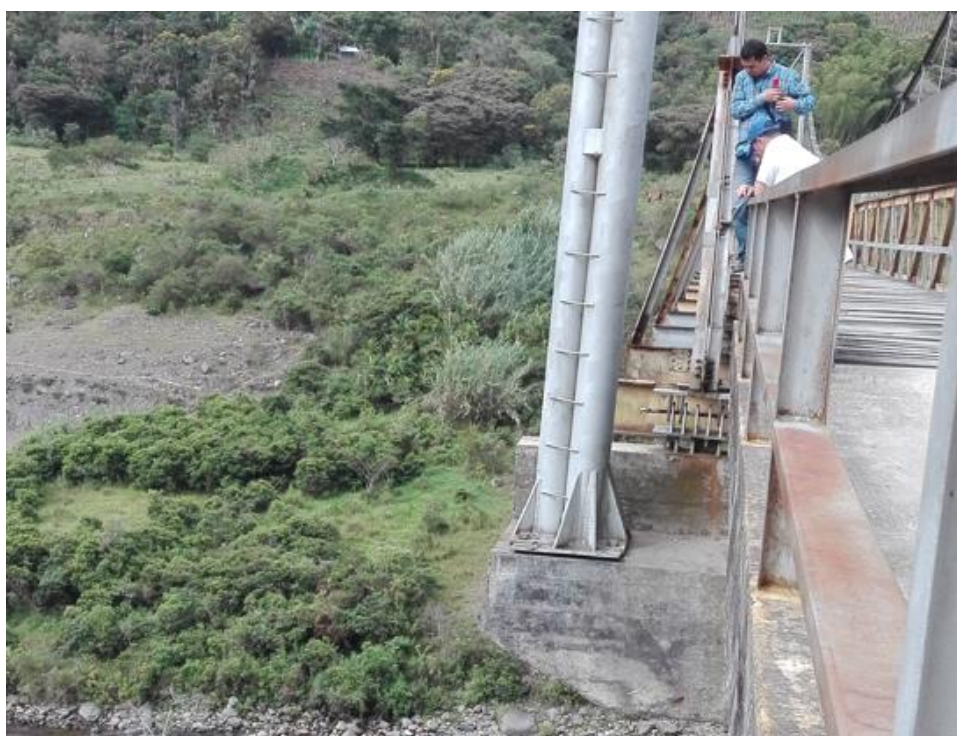
Figura 35. Viga cabezal vista desde el puente. Fuente propia.
