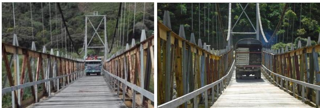
Figura 10. Vehículos con carga sobre el puente. Fuente JOYCO SAS
