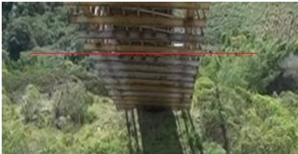
Figura 84. Recuperación del Peralte del puente
