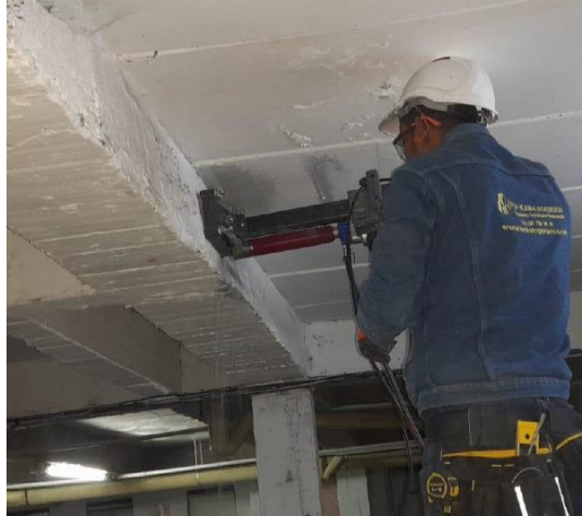
Ilustración 77. Toma de núcleos. Imagen de referencia.
