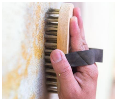
Ilustración 78. Imágenes de referencia. Intervención de eflorescencias.
