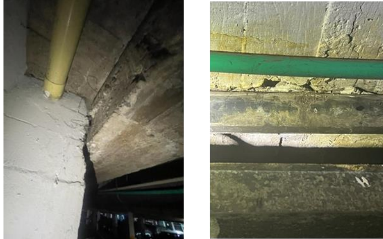
Ilustración 37. Fuente propia. (Conjunto Rincón de Techo II Ilustración, 2024) fotografía propia. Bogotá Colombia. Carbonatación.
