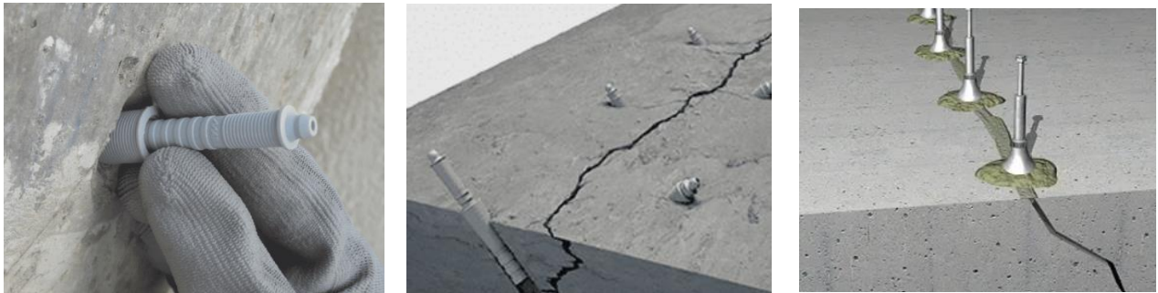
Ilustración 80. Imagen de referencia. Reparación de fisuras pasantes, pasvias.
