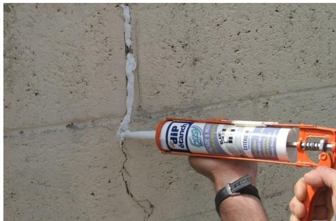
Ilustración 81. Imagen de referencia. Reparación de fisuras activas.
