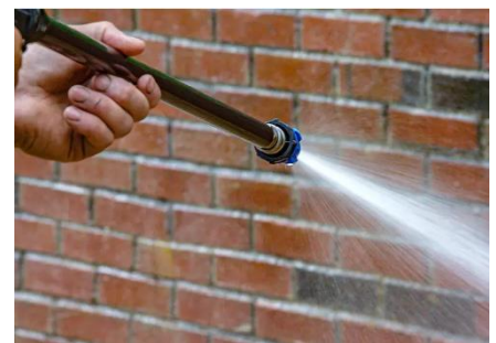
Ilustración 78. Imágenes de referencia. Intervención de eflorescencias.
