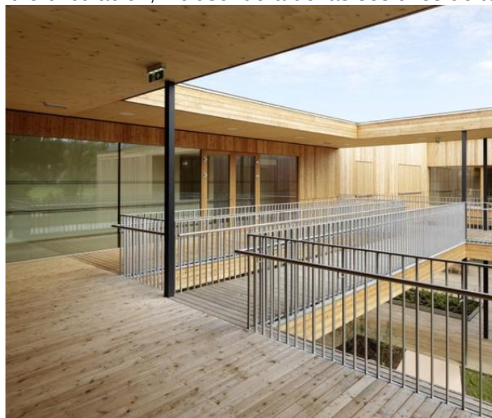
Pasillos y circulaciones a lo largo del equipamiento
