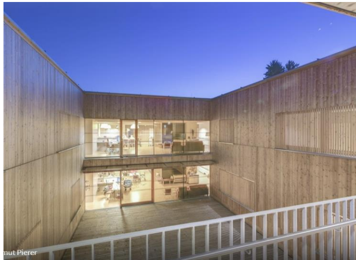
Patio central del equipamiento
