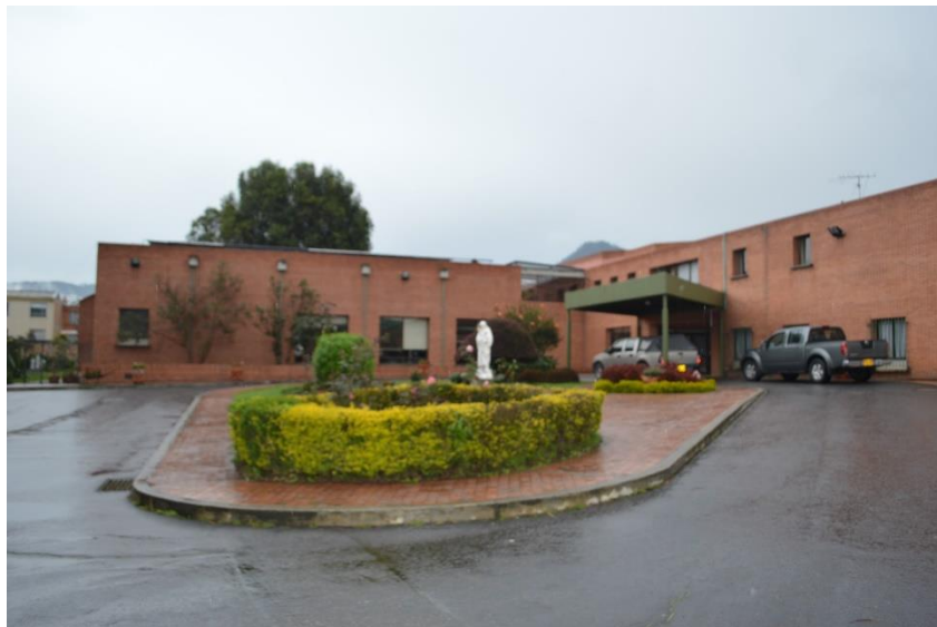
Plazoleta central interior y circulación sistema de parqueadero
