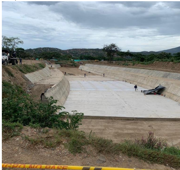
Figura 29. Ampliación canal, toma 1
