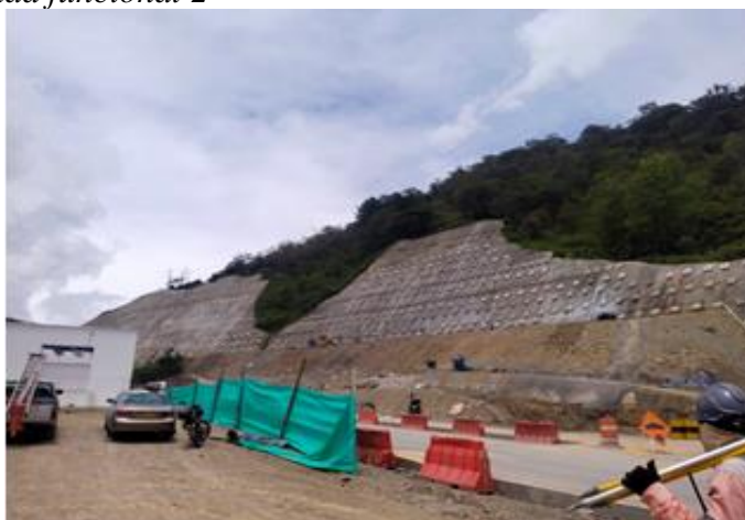
Figura 11. Peaje unidad funcional 2
