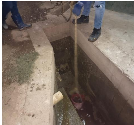
Figura 40. Toma de muestra entrada PTAR, toma 1
