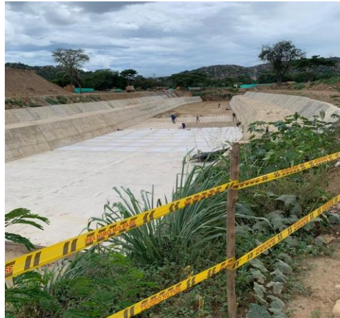
Figura 33. Ampliación canal vista desde el borde
