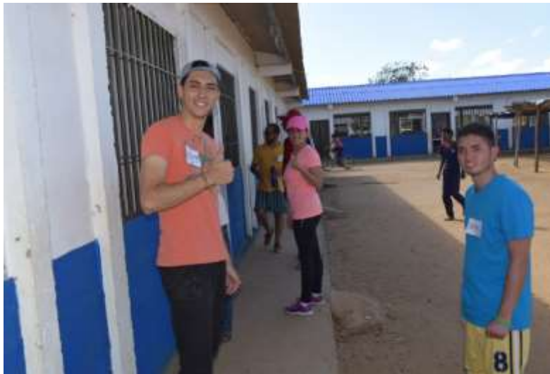
Figura 7. Estructura Salón colegio Ishashimana.
