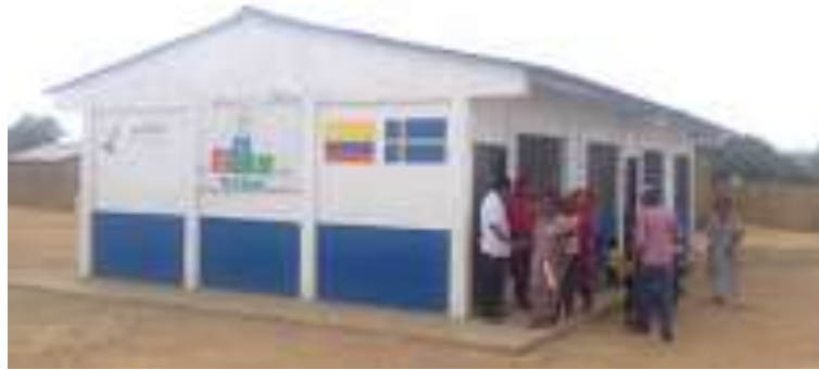
Figura 6. Estructura Salón colegio Ishashimana.
