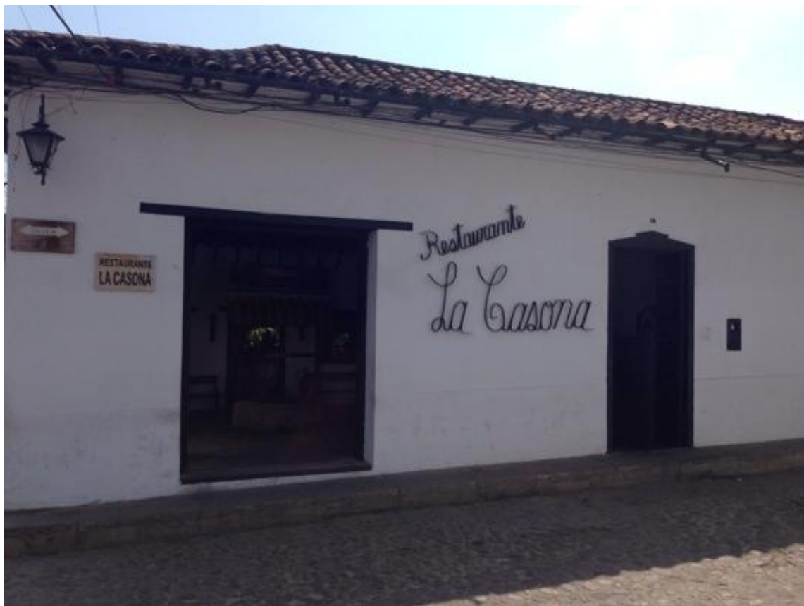
Figura 15. Edificación La Casona Restaurante.
