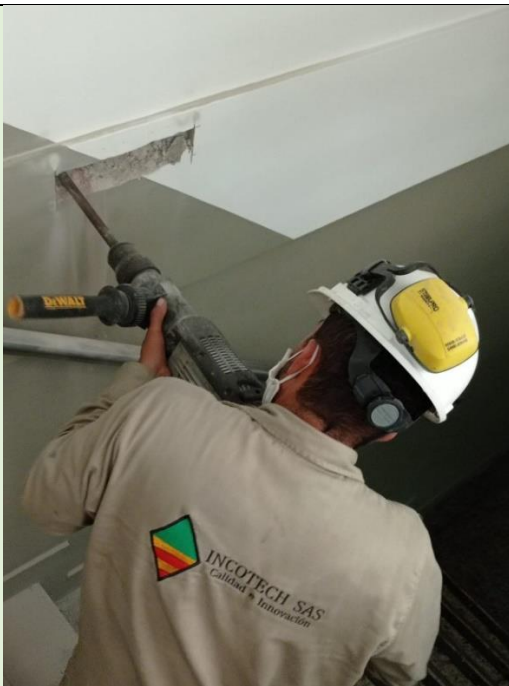
REGATAS – EXTRACCIÓN DE NÚCLEOS - VIGA
