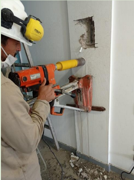
EXTRACCIÓN DE NÚCLEOS - COLUMNA
