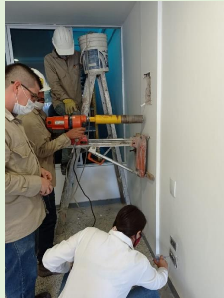
INSTALACIÓN DE EQUIPOS
