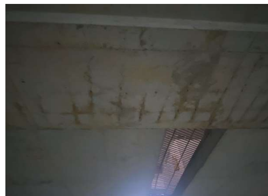
Foto 3. Viga VG-E placa nivel +1,25 sótano 1
