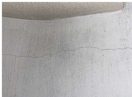
Foto 2. Muro no estructural escalera
