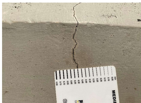
Foto 3. Alfajías en concreto parque infantil piso 2
