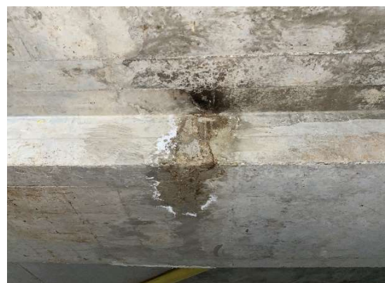
Foto 2. Viga VG-E placa nivel +1,25 sótano 1
