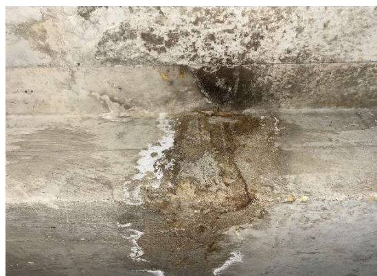
Foto 3. Viga VG-E placa nivel +1,25 sótano 1
