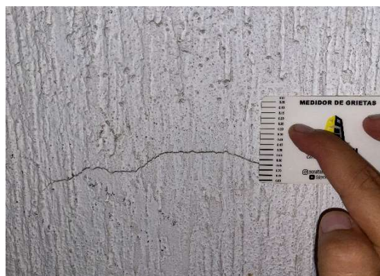
Foto 3. Muro no estructural escalera
