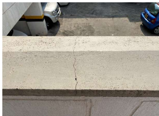
Foto 2. Alfajías en concreto parque infantil piso 2
