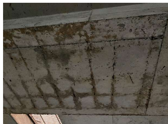
Foto 2. Viga VG-E placa nivel +1,25 sótano 1
