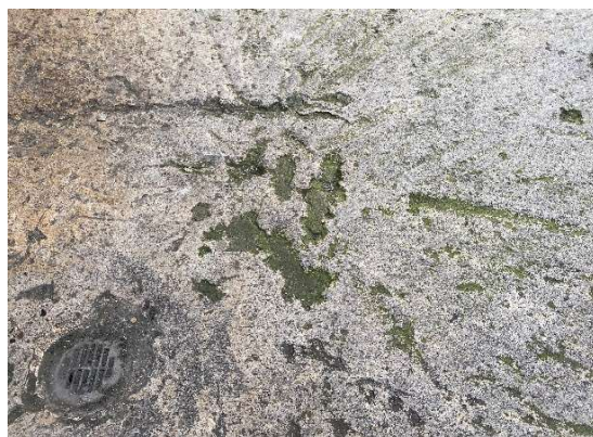
Foto 2. Placa parqueaderos nivel +1,25 piso 1
