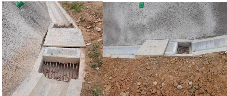
Figura 52. Vista canaleta de recolección de aguas lluvia
