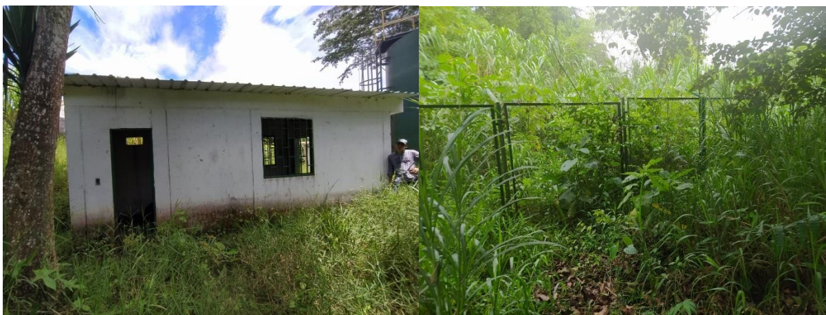
Figura 25. Caseta de control y malla de encerramiento
