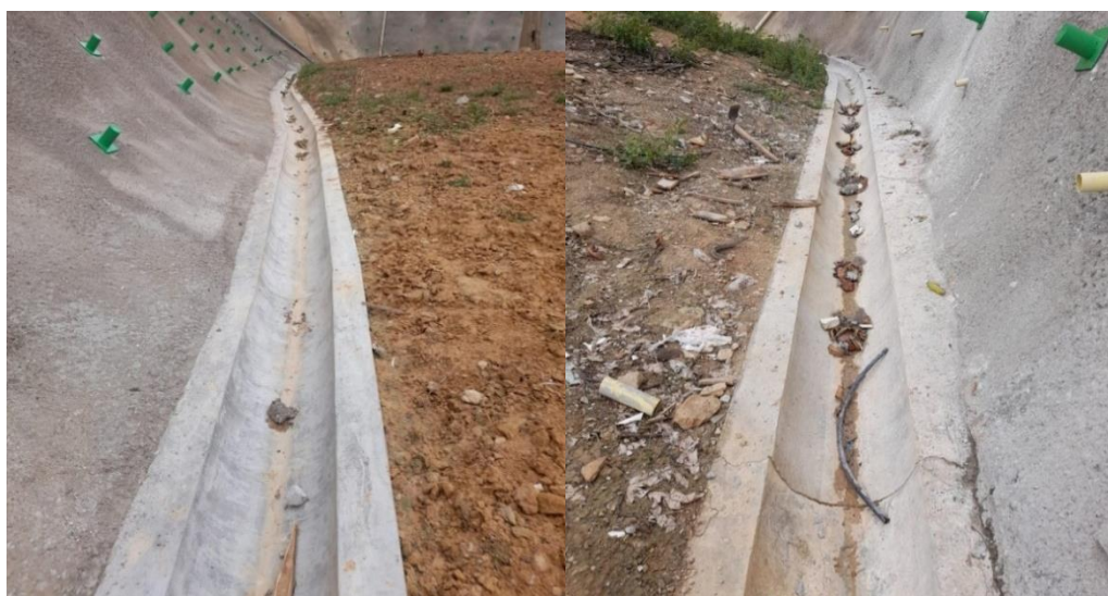
Figura 52. Vista canaleta de recolección de aguas lluvia
