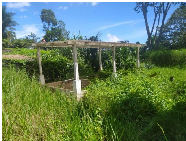
Figura 22. Lecho de secado
