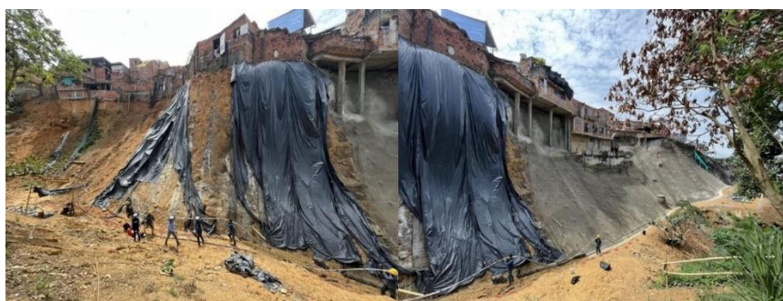
Figura 61. Obra Barrio Pablo VI
