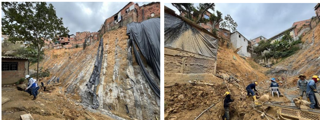
Figura 62. Obra Barrio Pablo VI
