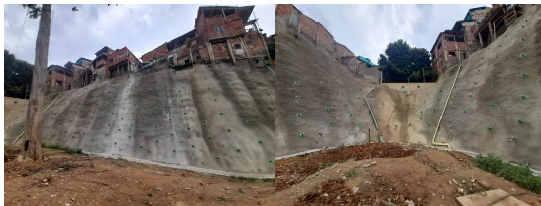
Figura 49. Vista general Pantalla anclada y Muro de contención
