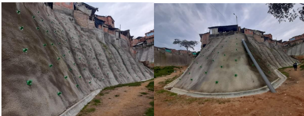
Figura 48. Vista general Pantalla anclada
