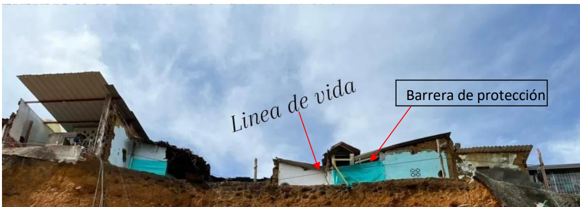
Figura 58. Instalación Línea de Vida
