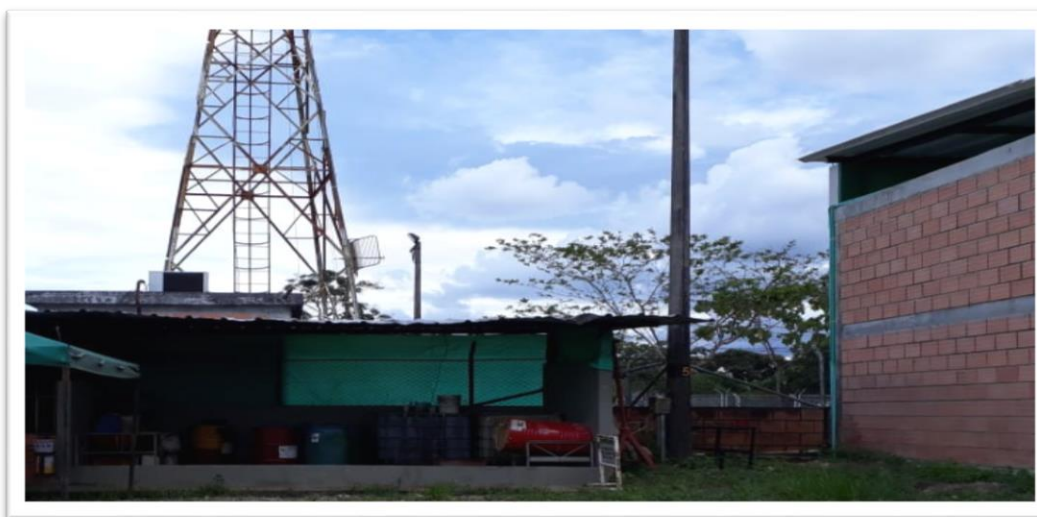
Imagen 15. Área de almacenamiento temporal de los residuos líquidos.
