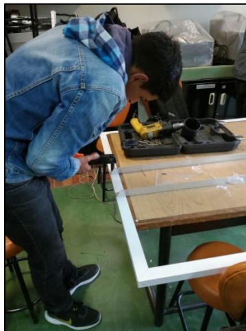
Figura 45. Construcción de soporte para paneles.
