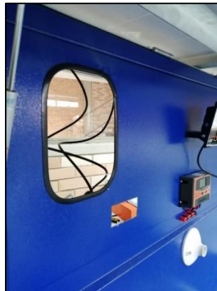
Figura 56. Cortes con Motortool para ensamble de caja de protecciones.
