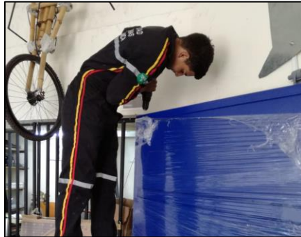
Figura 46. Adecuación de armazón para ensamble de paneles.
