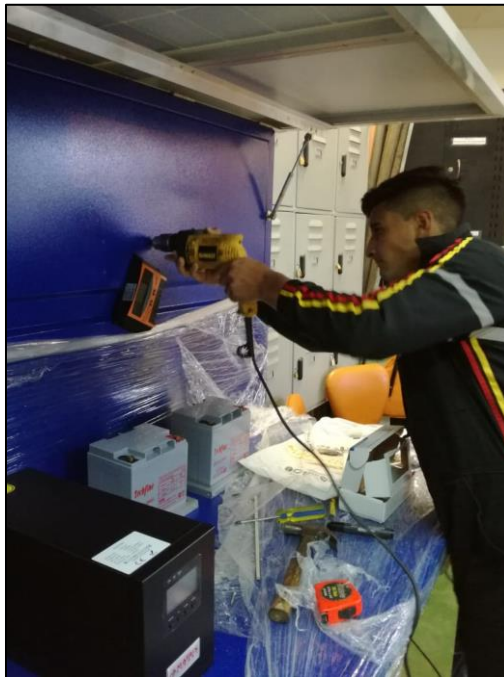
Figura 53. Taladrado e instalación de equipos.
