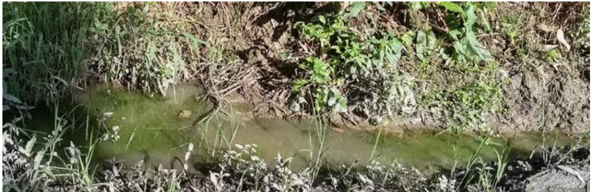
Fotografía No. 26. Agua estancada en la cuneta
