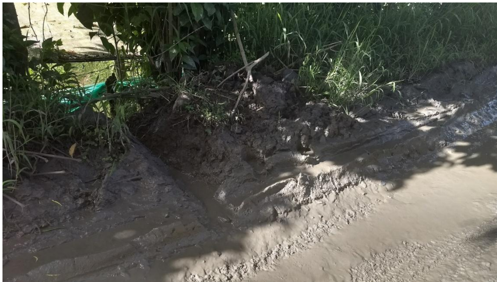
Fotografía No. 23. Drenaje incorrecto
