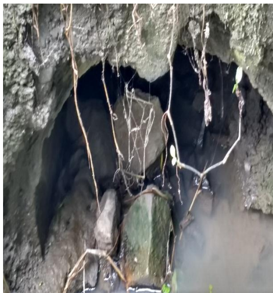
Fotografía No. 12. Tubería de encole de la alcantarilla
