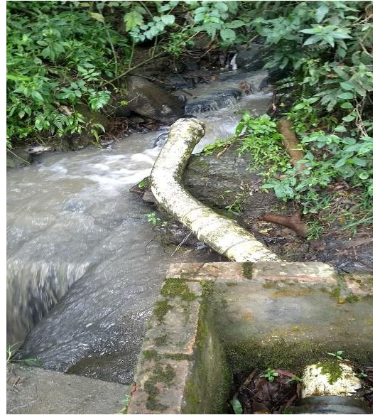
Fotografía No. 8. Purga de un sistema de riego.
