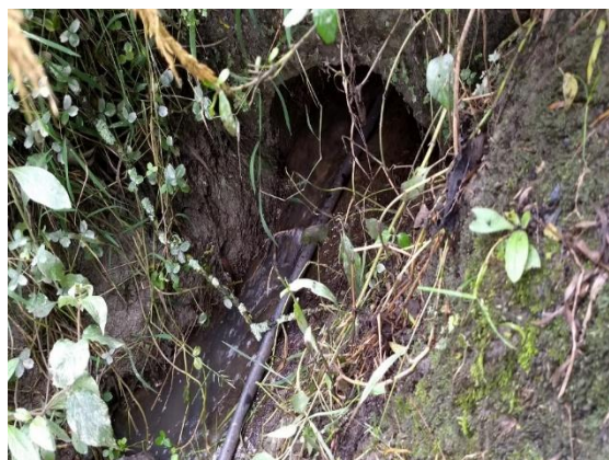
Fotografía No. 19. Descole de la alcantarilla
