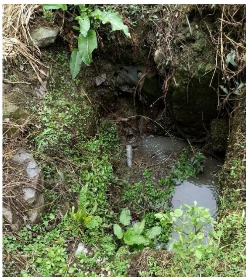
Fotografía No. 11. Encole de la alcantarilla
