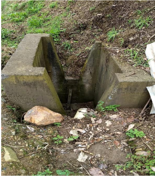
Fotografía No. 20. Estructura de la alcantarilla
