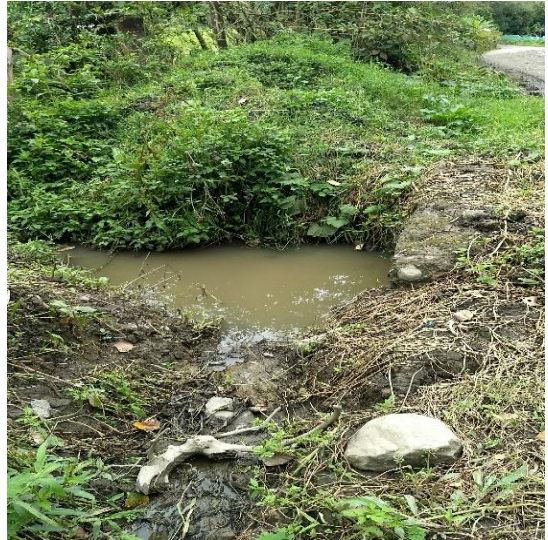
Fotografía No. 2. Estancamiento del agua proveniente de las cunetas.
