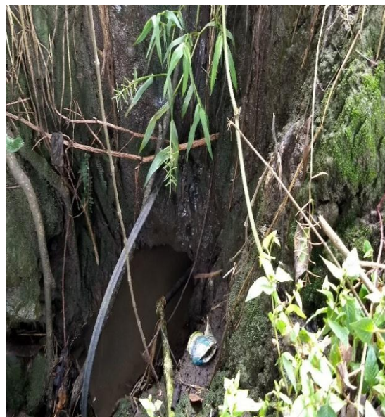
Fotografía No. 15. Descole de la alcantarilla
