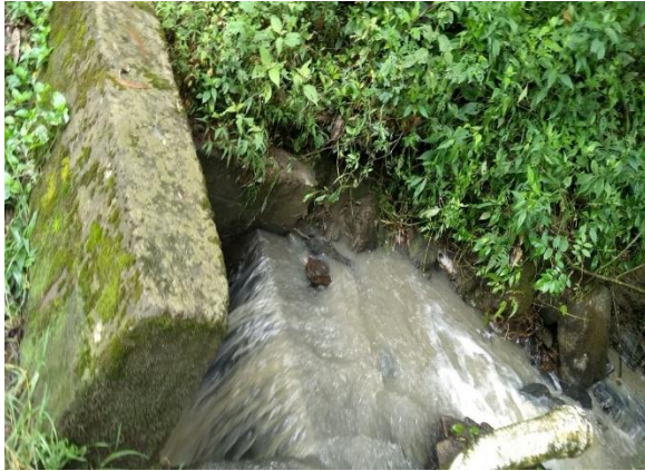
Fotografía No. 7. Estructura de la alcantarilla
