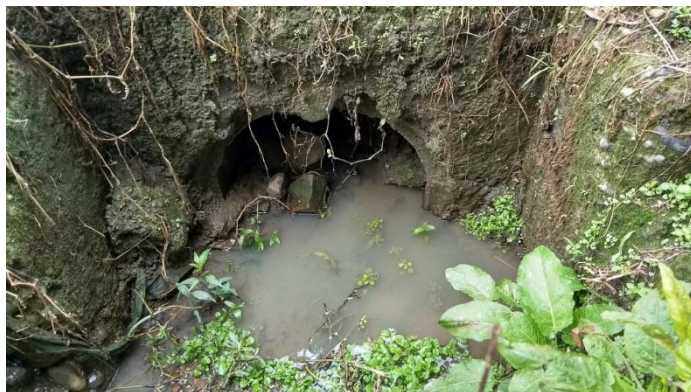
Fotografía No. 13. Descole de la alcantarilla.
