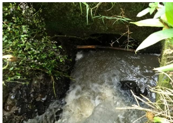
Fotografía No. 17. Tubería de encole de la alcantarilla
