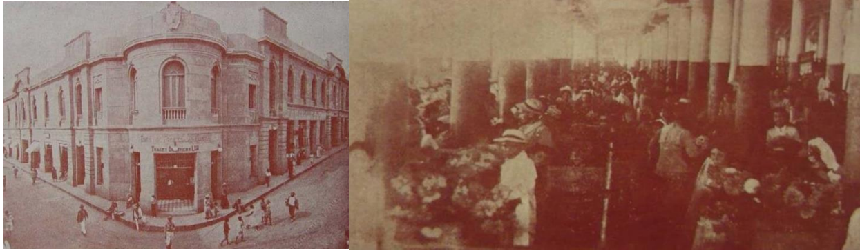
Figura 42. Vista exterior del pabellón de carnes de la plaza de mercado San Mateo y vista general.
