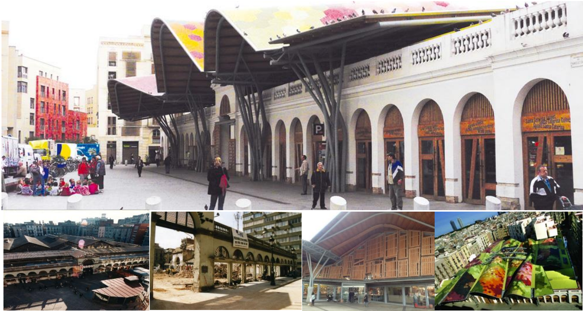
Figura 71. Vistas internas y externas del Mercat Santa Caterina.
