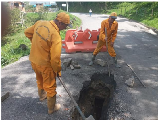
Figura 5. Mantenimiento e intervención en tramo de vía
