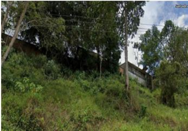
Figura 4. Inspección del área 5 y 6
