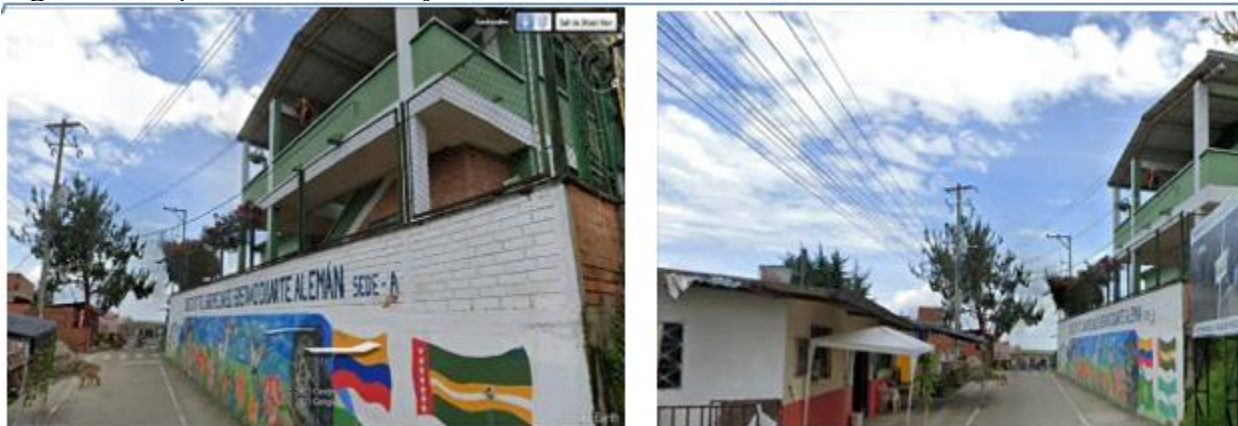
Figura 3. Inspección del área 3 y 4
