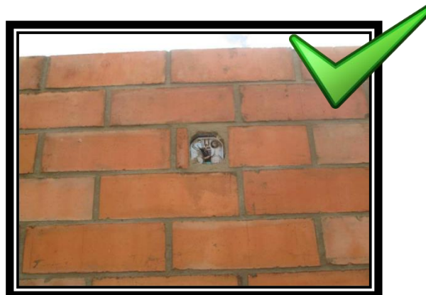
Figura 21. Vista clara de un proceso adecuado de instalación de redes en elementos de mampostería.
