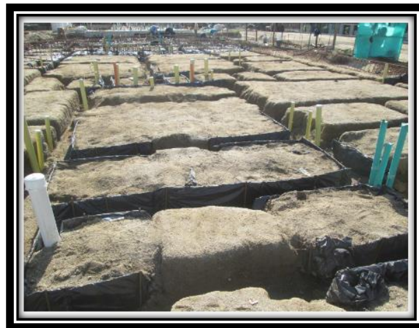
Figura 18. Trincheras de cimentación perfectamente definidas y excavadas antes de la fundición. Urbanización la gloria, Florencia - Caquetá.
