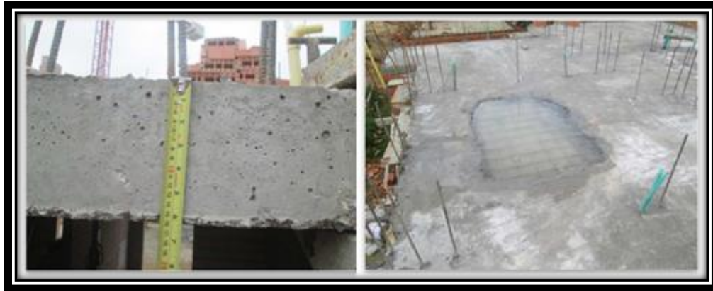
Figura 16. Placa de 15 cm de entrepiso con presencia de hormigonero, urbanización la gloria, Florencia - Caquetá.
