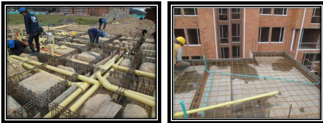
Figura 20. Colocación de refuerzo adicional en pases de tubería. Urbanización La Gloria, Florencia - Caquetá.
