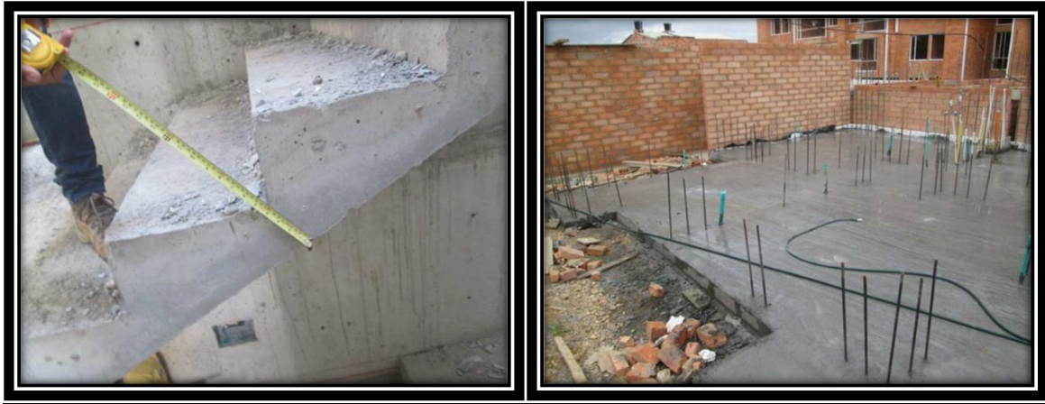
Figura 17. El supervisor técnico siempre verificará las dimensiones de los elementos antes durante y después del trabajo de fundición, así como el curado del mismo, urbanización la gloria, Florencia - Caquetá.
