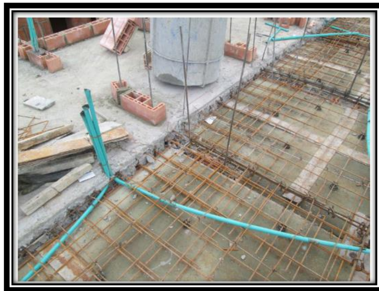
Figura 15. Detalles de instalación de redes eléctricas en la placa de entre piso, para estructura de mampostería estructural de la urbanización la gloria, Florencia - Caquetá.
