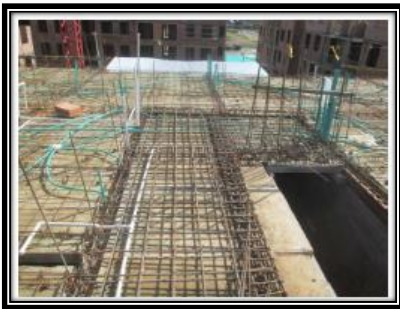
Figura 12. Disposición y armado del acero en placa entrepiso con sus respectivas instalaciones.
