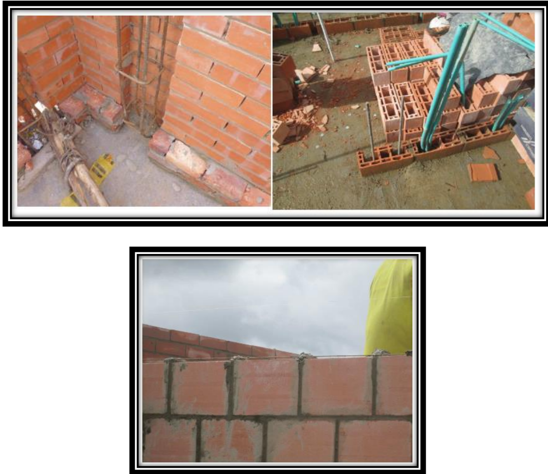
Figura 13. Instalación del acero vertical para columnas de confinamiento o instalaciones en dovelas e instalación de aceros horizontales llamados grafiles.
