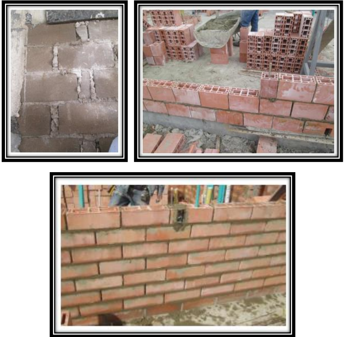
Figura 7. Unidades de mampostería
