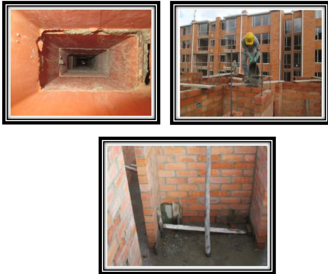
Figura 9. Verificación de cavidad de la celda, vaciado del Grouting y sellado de ratoneras.
