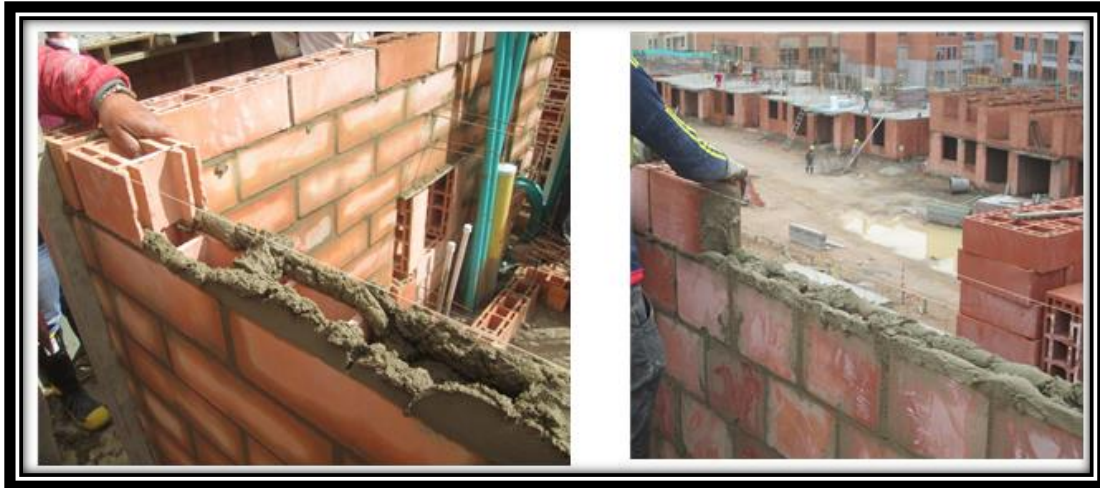
Figura 10. Correcta colocación del mortero de pega tanto en los laterales como en divisiones internas.
