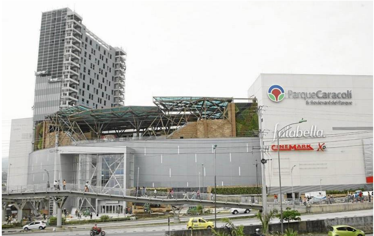
Figura 64. Centro Comercial Parque Caracolí. Fuente: Google imágenes.
