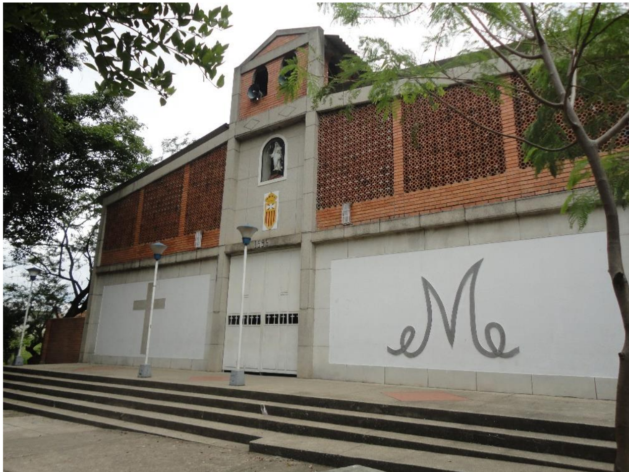
Figura 69. Parroquia Santa María de los Lagos. Fuente: Google imágenes.
