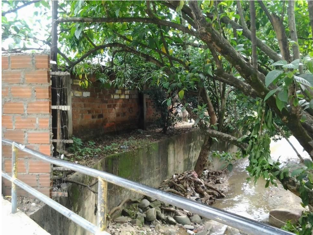
Figura 4. Situación de la edificación en el costado posterior. Fuente: autor.
