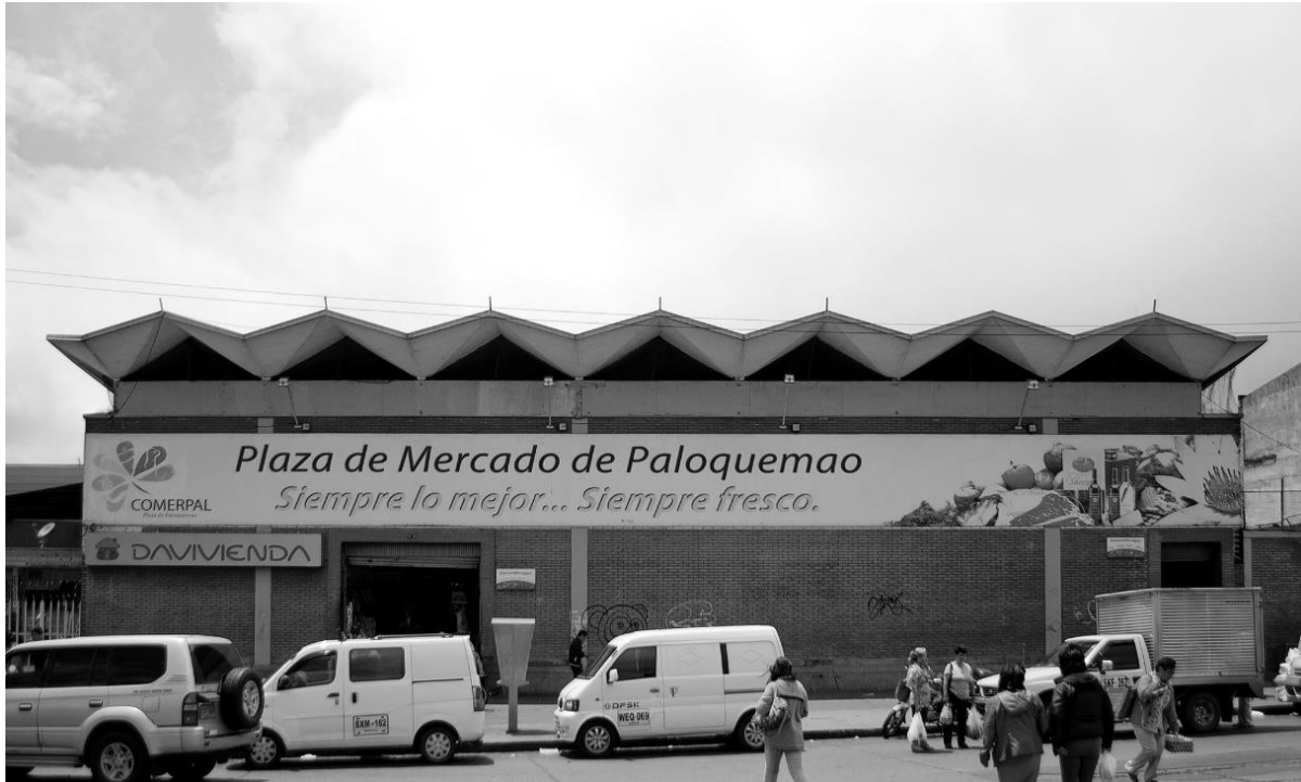
Figura 36. Fachada acceso principal. Fuente: http://www.archdaily.co/co/626045/clasicos-de-arquitectura-plaza-de-mercado-de-paloquemao-dicken-castro-jacques-mosseri
