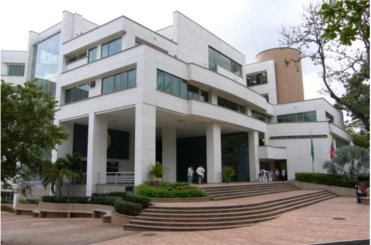
Figura 67. USTA Campus Floridablanca. Fuente: Google imágenes.
