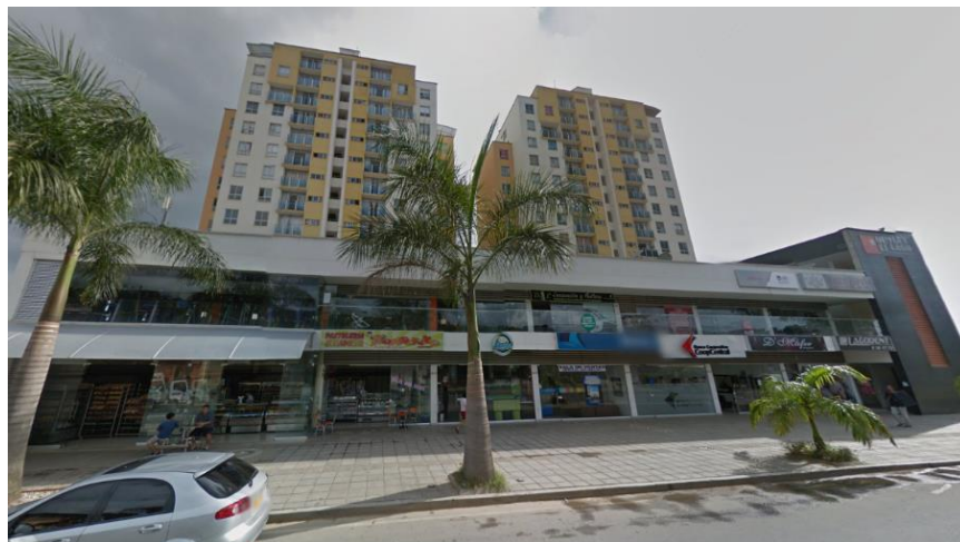
Figura 60. Edificaciones recientes en Lagos III. Fuente: Google maps.
