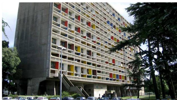
Figura 74. Unidad de Habitación. Adaptada de http://moleskinearquitectonico.blogspot.com.co/2010/04/le-corbusier-unite-dhabitation-de.html . 2015.
