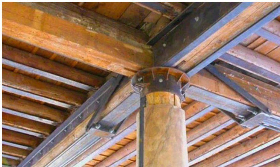
Ilustración 51. PROPUESTA DE REFORZAMIENTO METALICO
