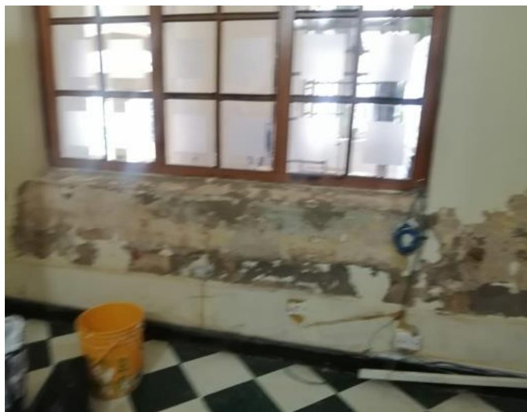
Ilustración 9. Humedad por Capilaridad
