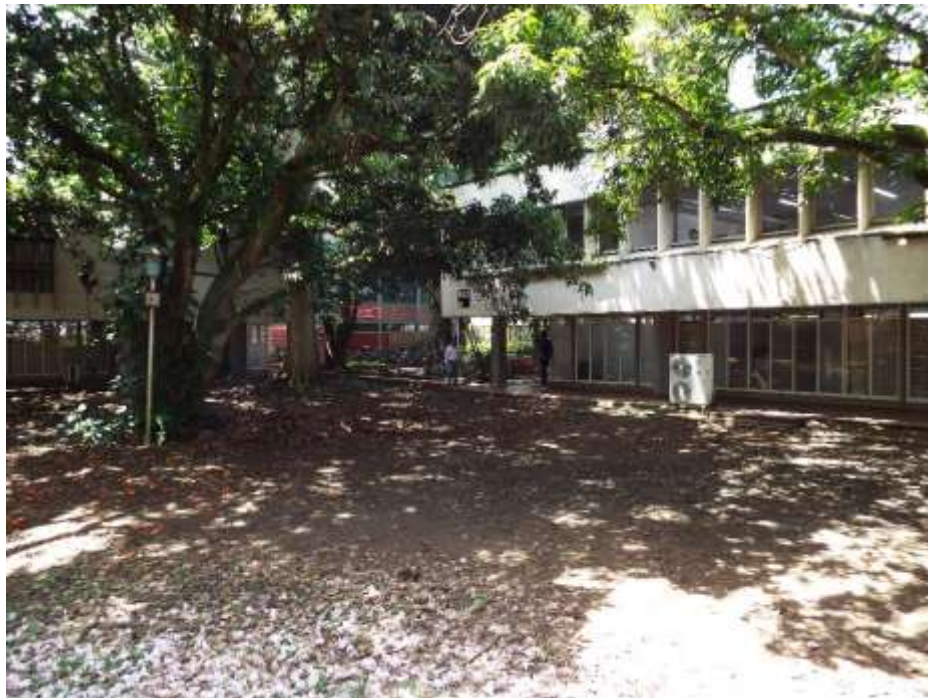
Imagen 32 Al fondo edificio en ladrillo con estudio de suelos de Geocontrol, a la izquierda edificio 355 estudiado por Gomez y Rauch
