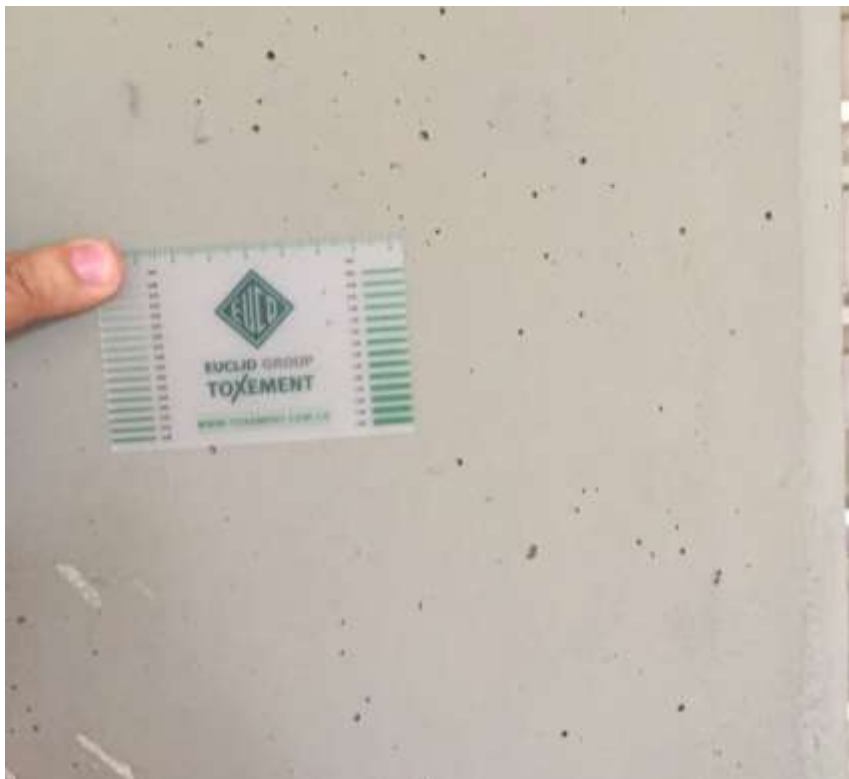
Imagen 29 Superficie de concreto de columnas
