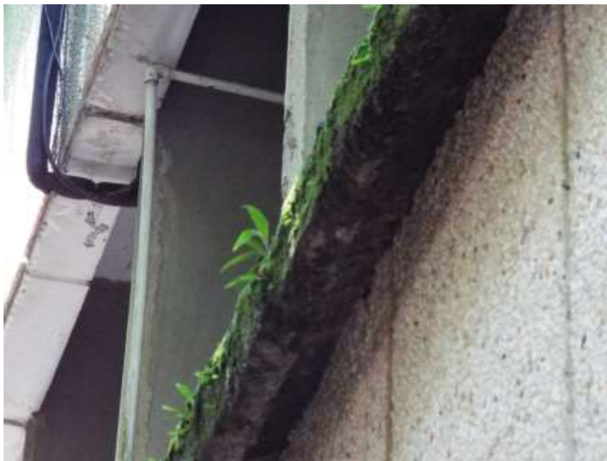
Imagen 46 Crecimiento de vegetación en la superficie del concreto
