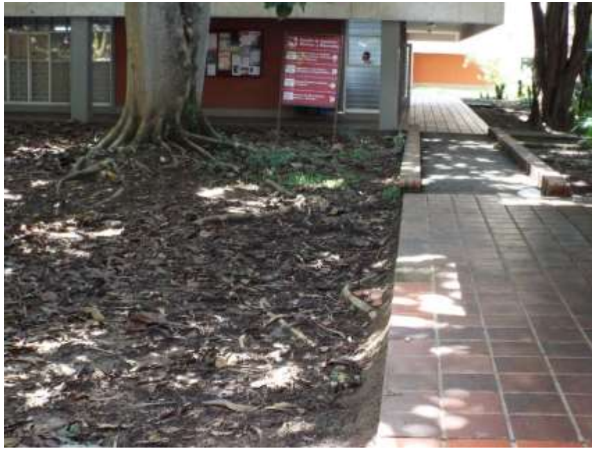
Imagen 48 Árbol de caucho con radiculación hacia la edificación
