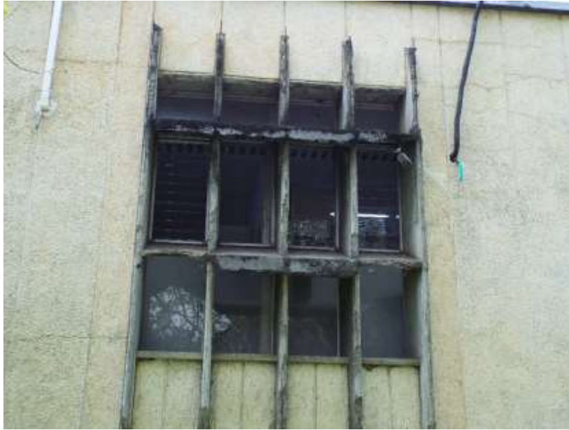
Imagen 11 Celosías prefabricadas de concreto sobre las ventanas de fachada
