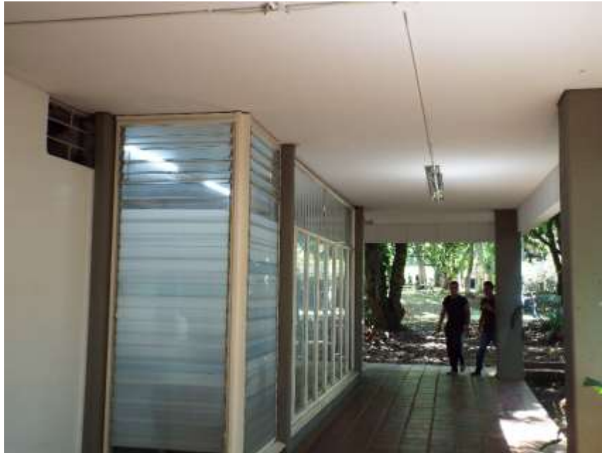
Imagen 31 Columnas en buen estado de conservación visual
