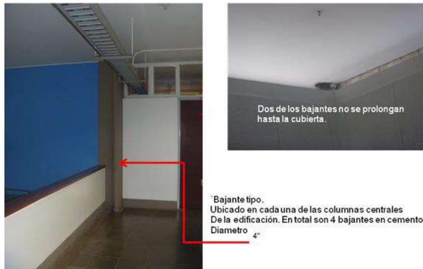
Imagen 53 Bajantes de aguas lluvias
