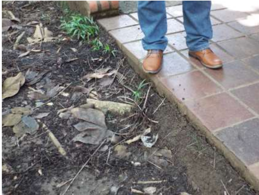
Imagen 52 Ingreso de raíz de caucho bajo el anden
