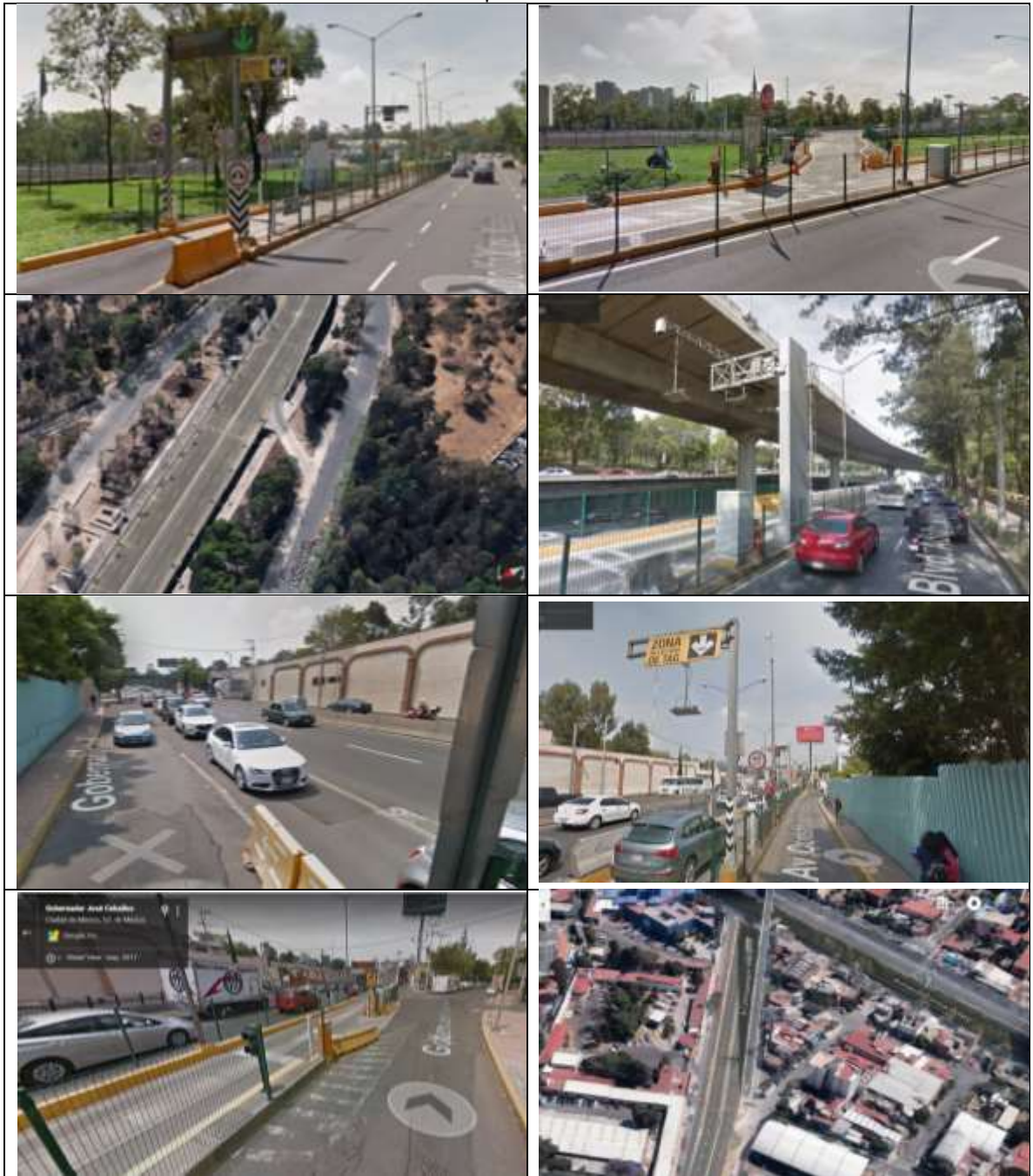
Ilustración 11. Autopista Urbana Norte México
