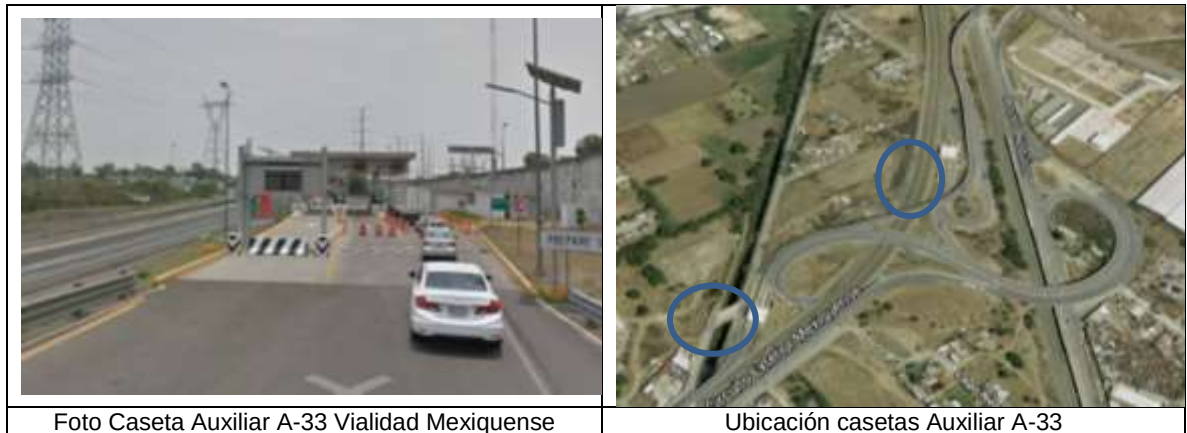
Ilustración 4. Caseta auxiliar A-33 – México
