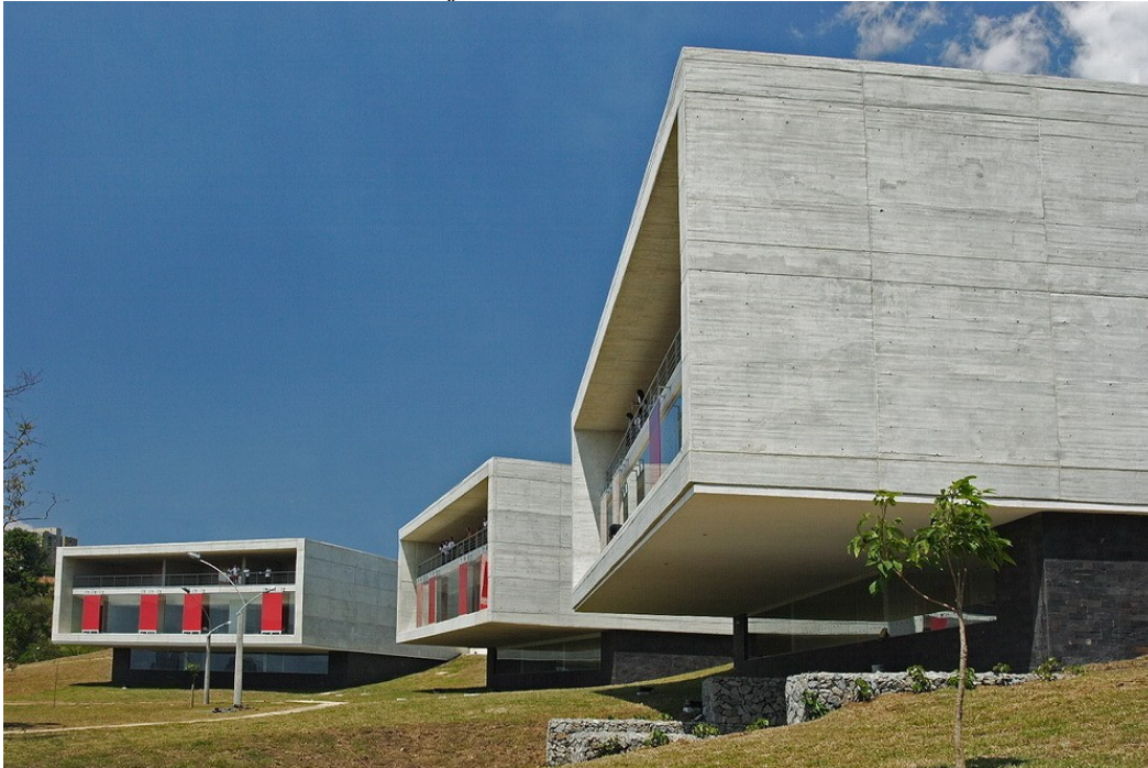
Figura 10 Vista desde terreno hacia la fachada
