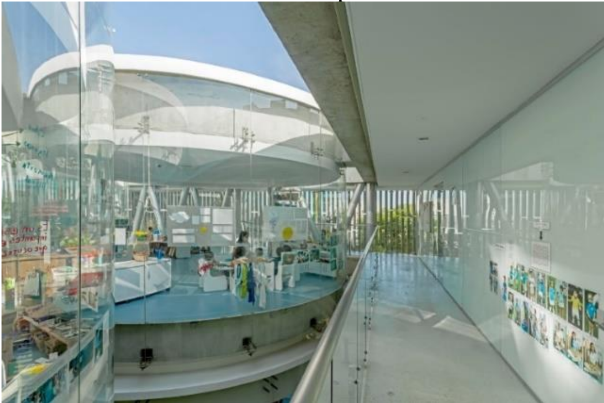
Figura 22. Vistas internas de pasillo.
