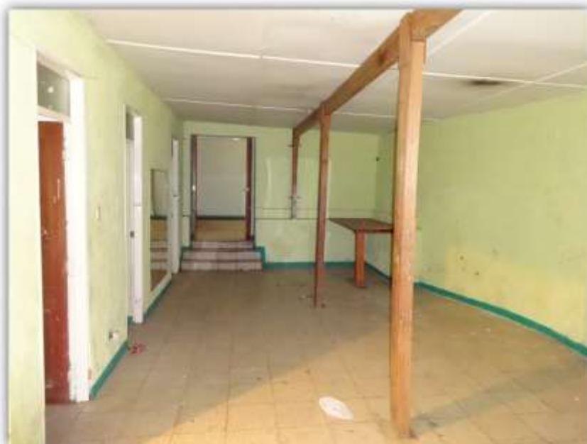
Vista hall lateral de acceso a camerinos
