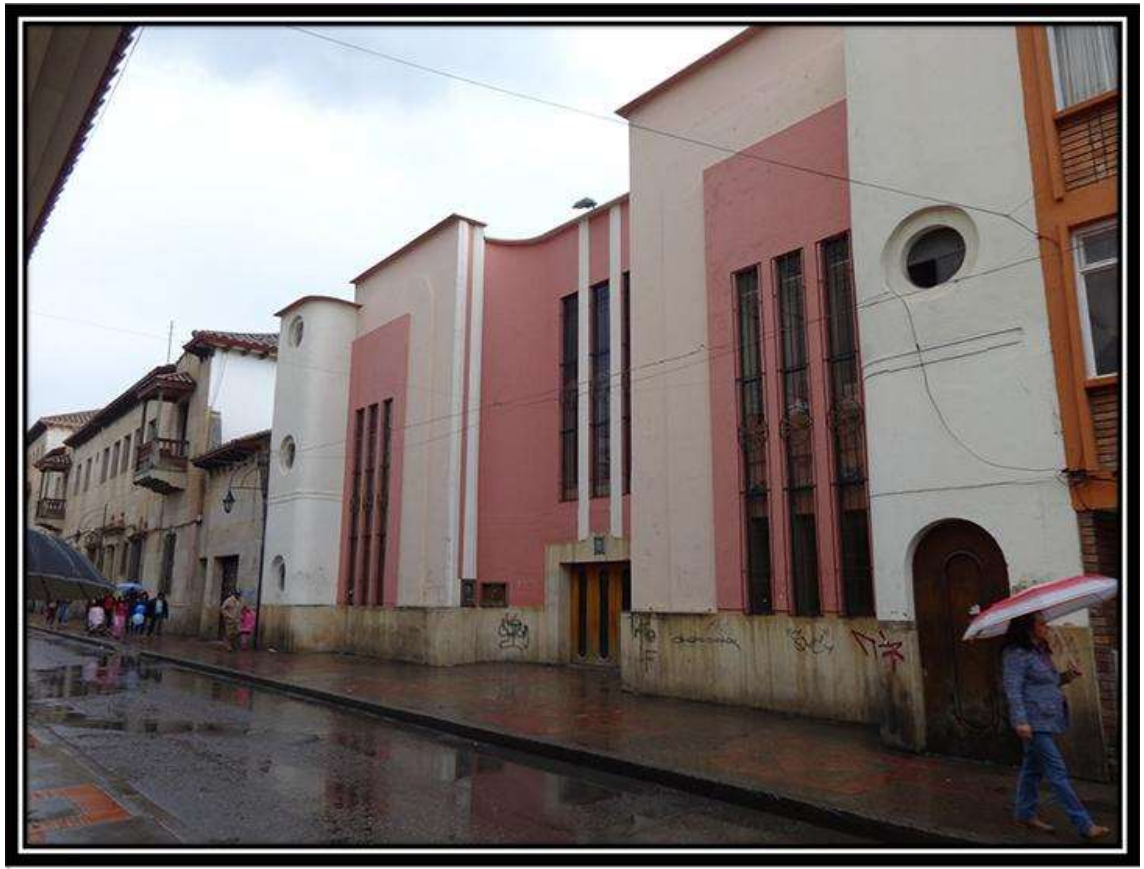
Levantamiento Fotográfico de la edificación
