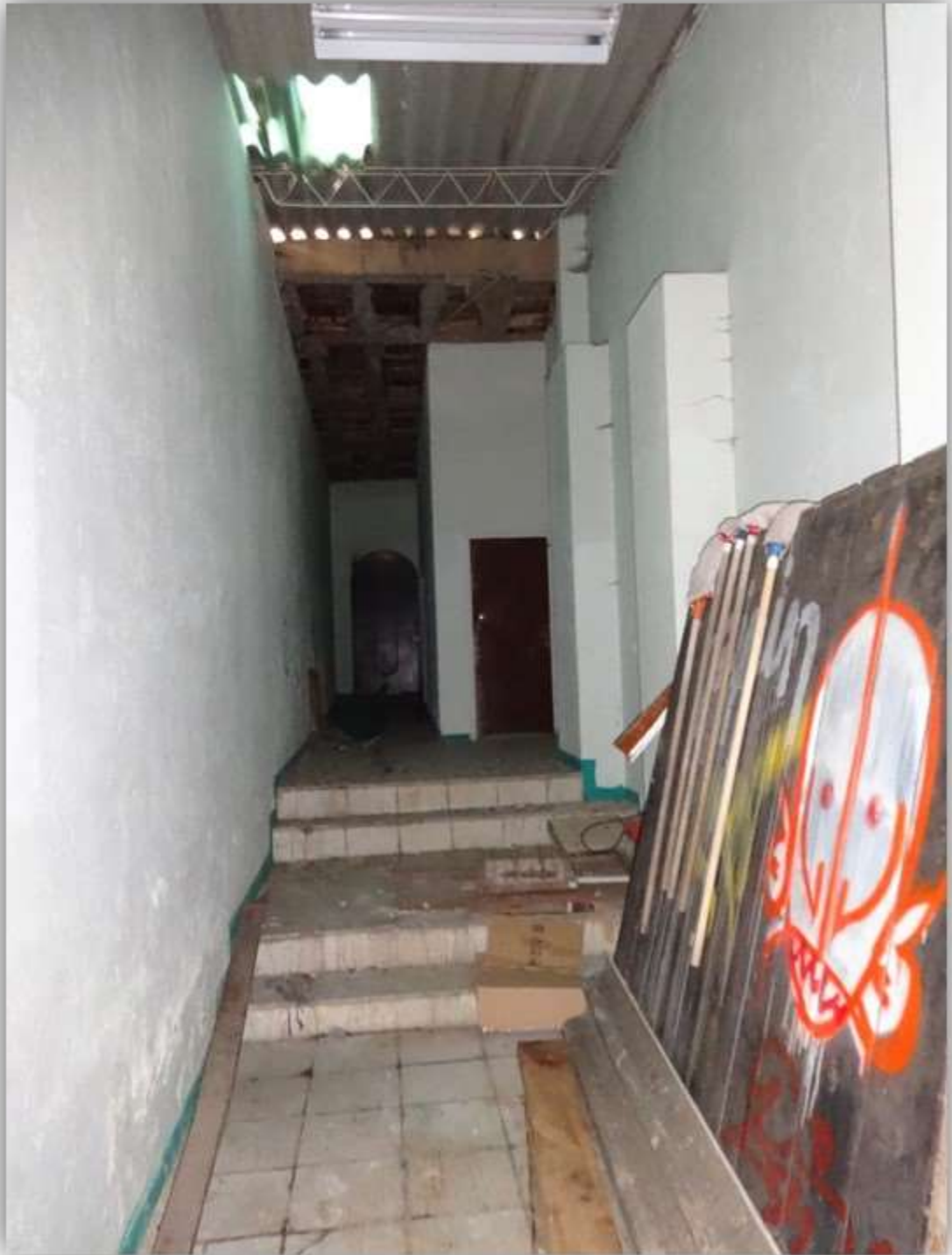
Vista hall lateral de acceso a camerinos
