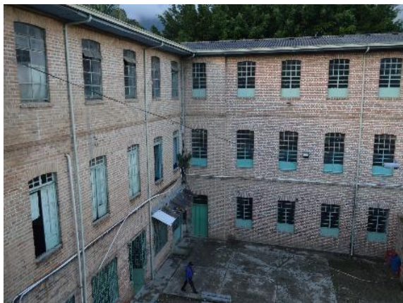
Ilustracion 38 -Detalle tuberías en asbesto cemento patio interior/ fuente consultor
