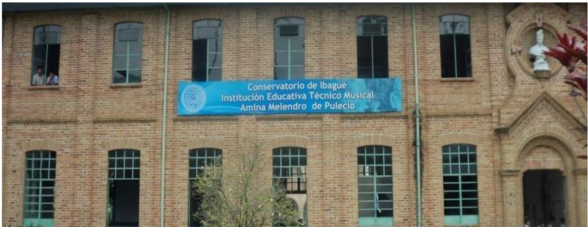
Ilustración 14-Fachada Principal Granja San Jorge / consultor
