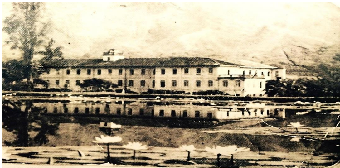
Ilustración 1 Fachada sur Granja San Jorge 1942 (Ibagué) / Archivo fotográfico Banco de la República
