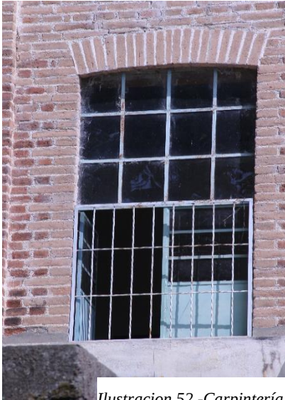
Ilustracion 52 -Carpintería Metálicas sobre fachadas/fuente consultor
