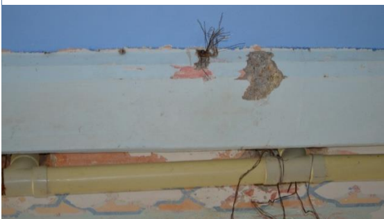
Ilustracion 44 -Detalle empalmes de redes sanitarias sobre placas de entepiso/fuente consultor
