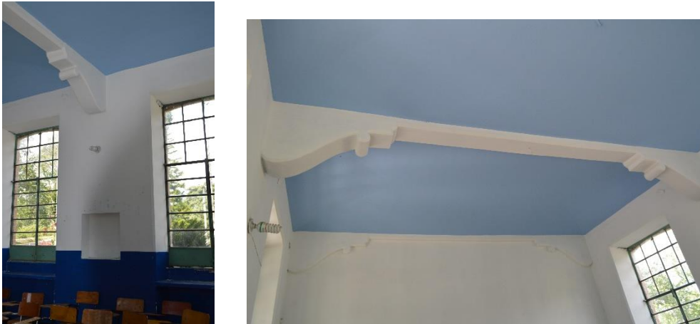
Ilustracion 31 Registro Vigas de borde en el sistema de bóvedas. / Fuente consultor
