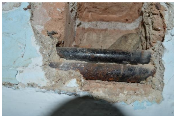
Ilustracion 48 -Detalle redes eléctricas exteriores /fuente consultor
