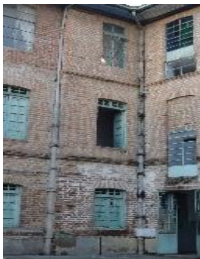
Ilustracion 37 -Detalle bajante de aguas lluvias en tubería asbesto cemento/fuente consultor
