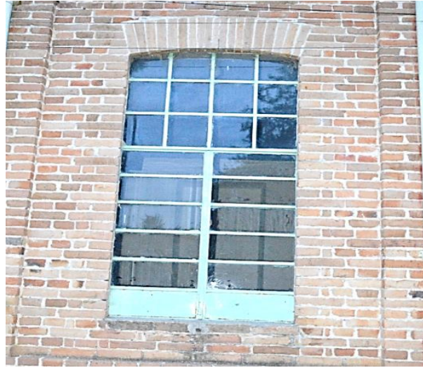
Ilustracion 52 -Carpintería Metálicas sobre fachadas/fuente consultor
