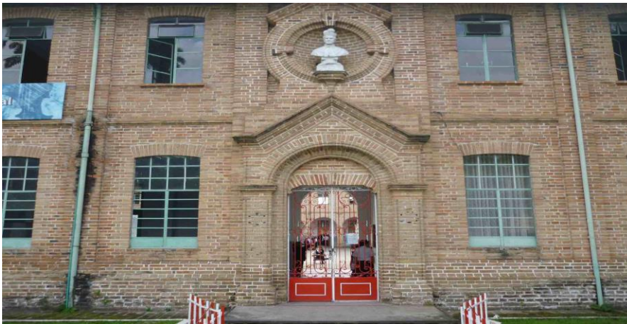
Ilustración 5 Fachada Occidente -fuente Carlos H.Diaz/ consultor
