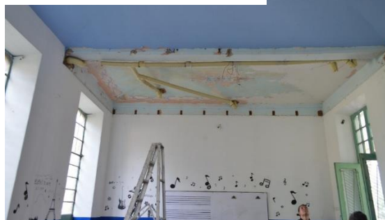
Ilustracion 44 -Detalle empalmes de redes sanitarias sobre placas de entepiso/fuente consultor
