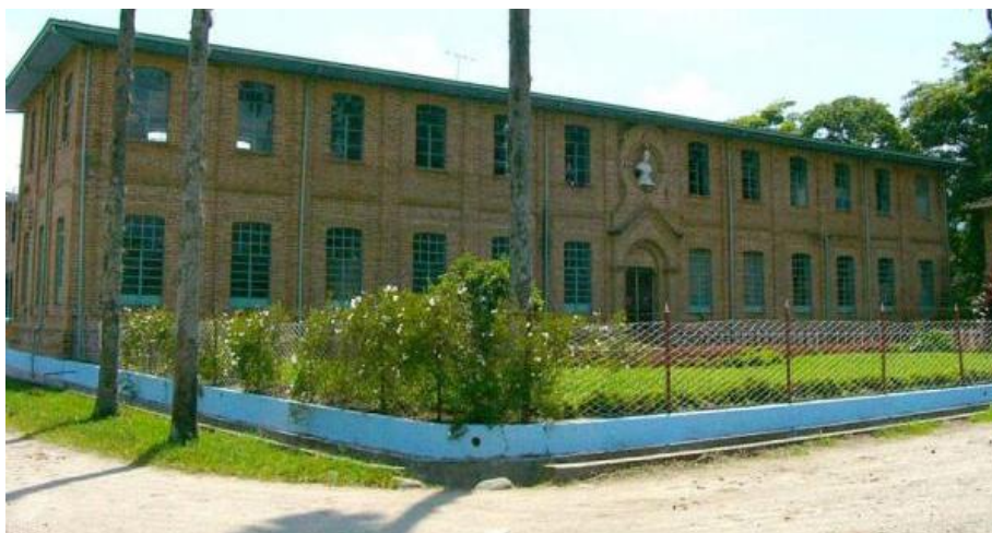
Ilustración 15 -Fachada Principal Granja San Jorge / consultor
