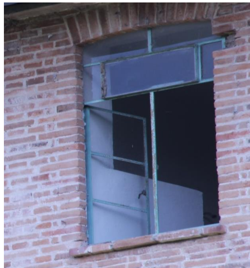
Ilustracion 53 Ventana lamina metálica en fachadas/fuente consultor
