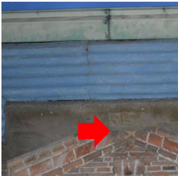
Ilustracion 32 -Viga de confinamiento muro en concreto armado /consultor
