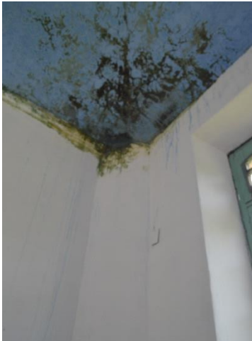
Ilustracion 45 -Detalle humedades producidas por redes sobre placas de entepiso/ fuente consultor
