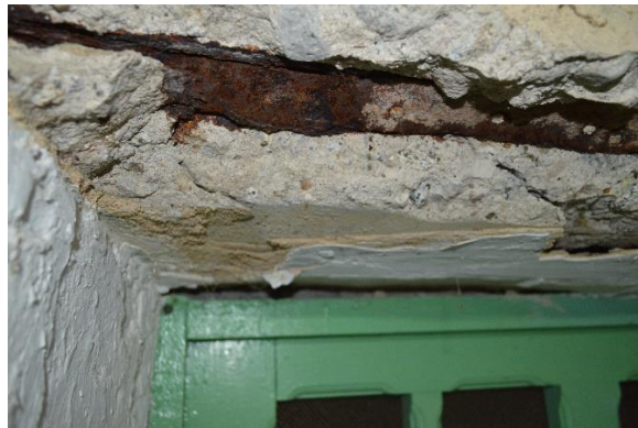
Ilustracion 45 -Detalle humedades producidas por redes sobre placas de entepiso/ fuente consultor
