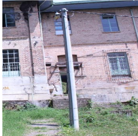
Ilustracion 51 -postes de energía de ocho metros /fuente consultor
