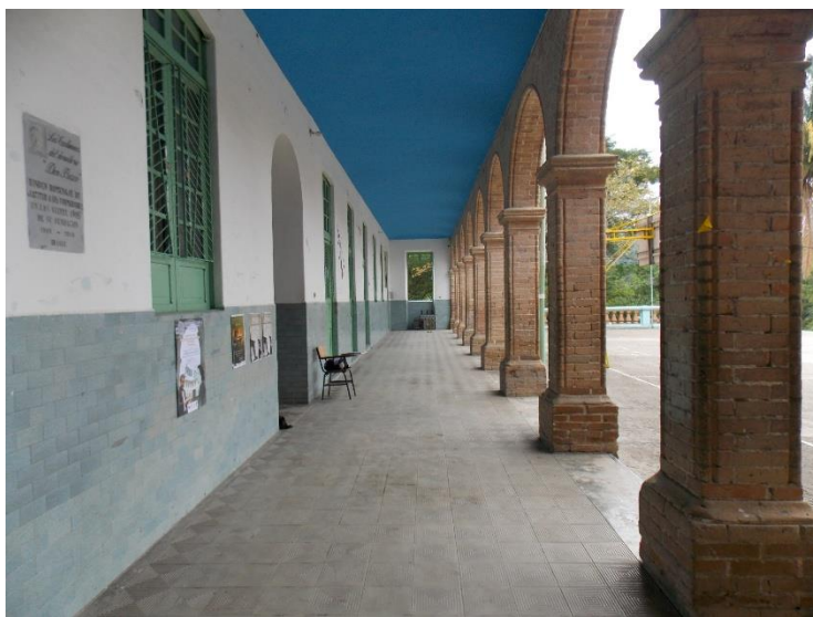
Ilustración 61 Detalle tipo de acabados de piso en Baldosa de cemento en relieve /fuente consultor
