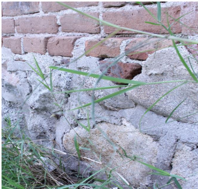
Ilustración 20 -Detalle aparejo cimiento con muro/fuente consultor
