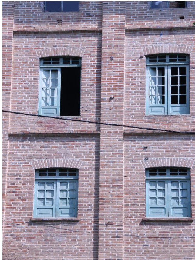
Ilustracion 22 -Estructura muro de carga/fuente consultor
