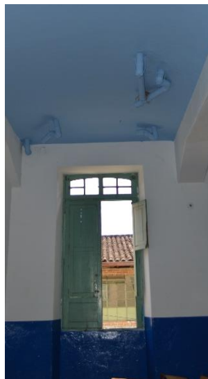
Ilustracion 44 -Detalle empalmes de redes sanitarias sobre placas de entepiso/fuente consultor
