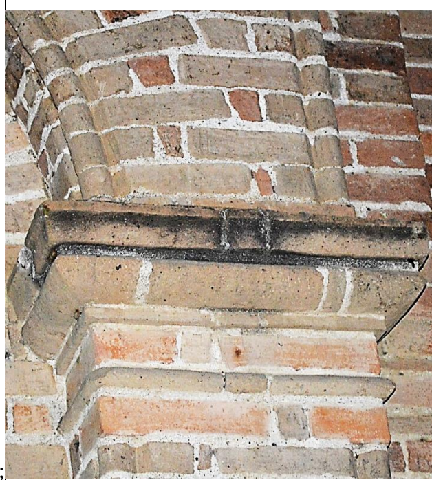
Ilustración 23 -Detalle arco de medio punto arcada interior /fuente consultor
