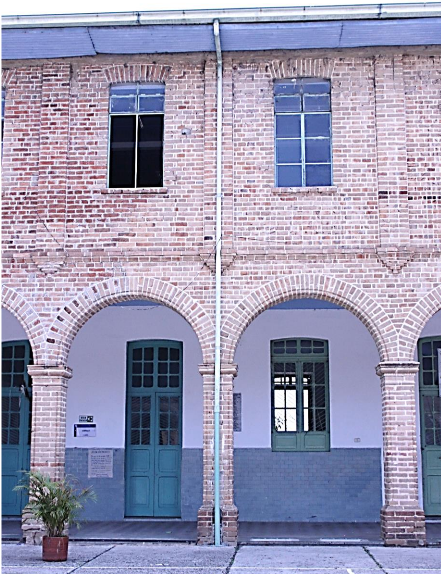
Ilustración 24 -Alzado arquería y bajante/fuente consultor
