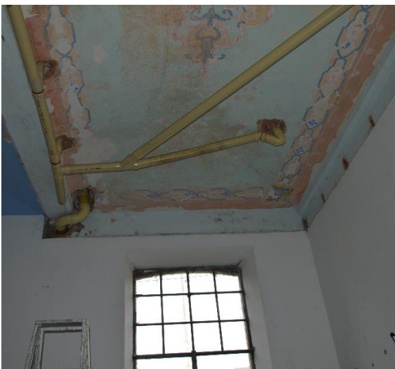
Ilustracion 44 -Detalle empalmes de redes sanitarias sobre placas de entepiso/fuente consultor
