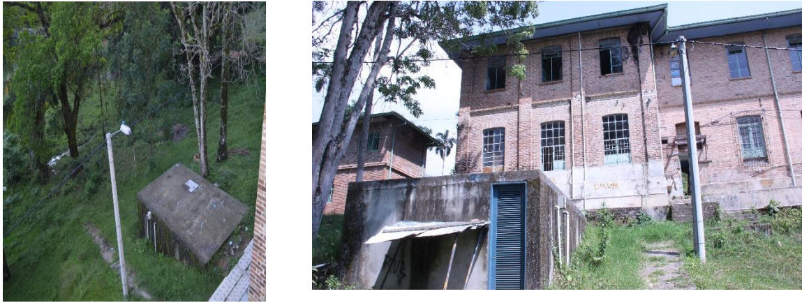
Ilustracion 34 -Detalle tanque de almacenamiento/ fuente consultor
