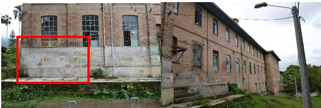
Ilustración 63 Corredores perimetrales fachada sur /fuente consultor
