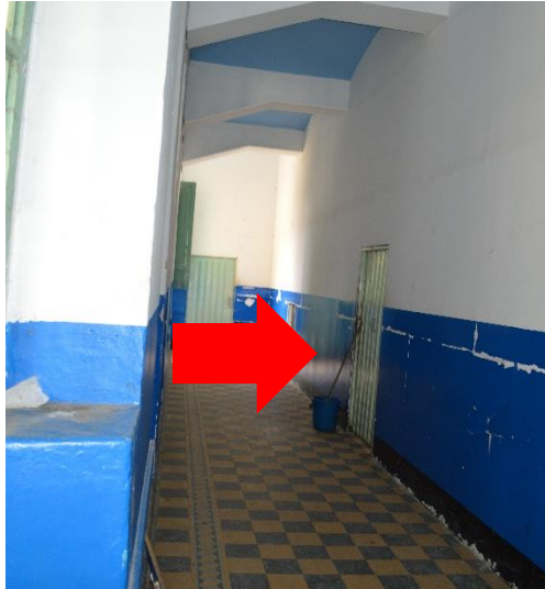
Ilustracion 25 -Muros divisorios/fuente consultor
