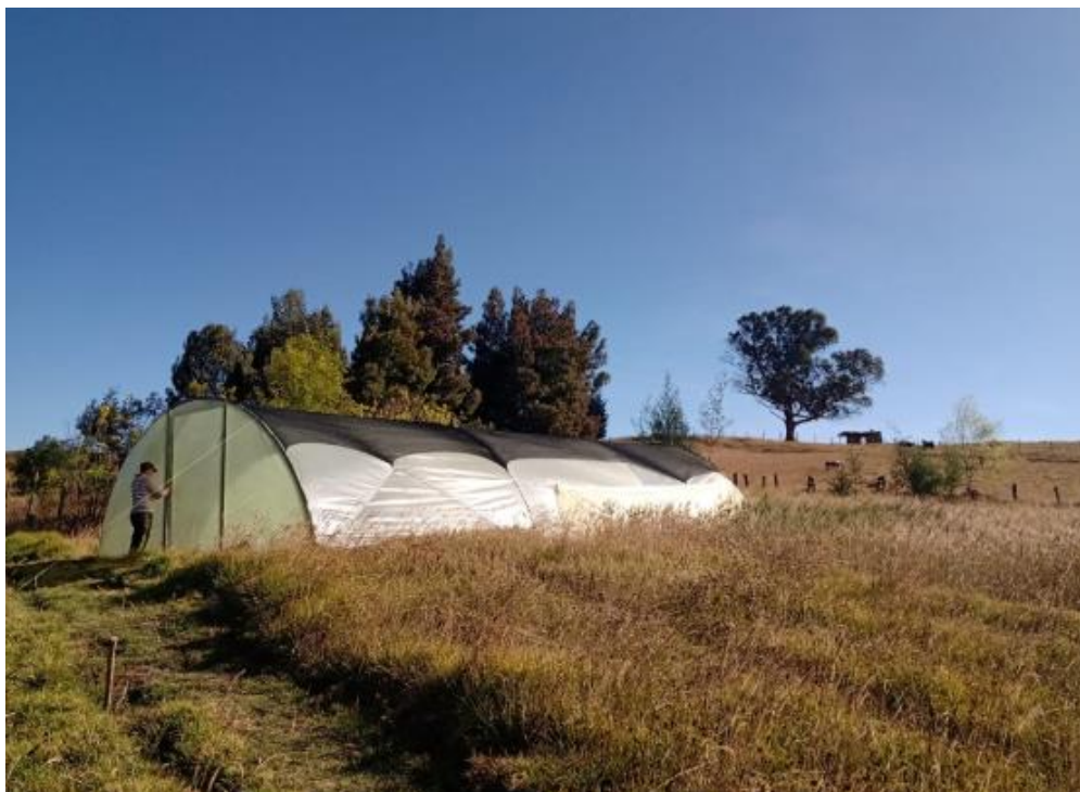
Figura 5 Estructura del invernadero (Autores).
