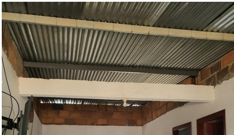
Figura 53 Cubierta lámina de zinc vivienda
