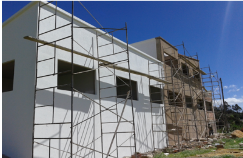
Ilustración 31. Proceso constructivo de fachada posterior ESE
