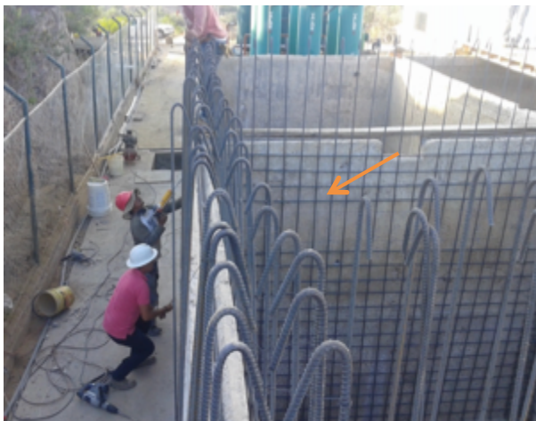
Ilustración 52. Instalación de reforzamiento en muros
