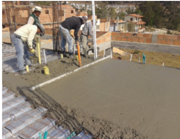
Ilustración 15. Instalación de placa Steel Deck.
