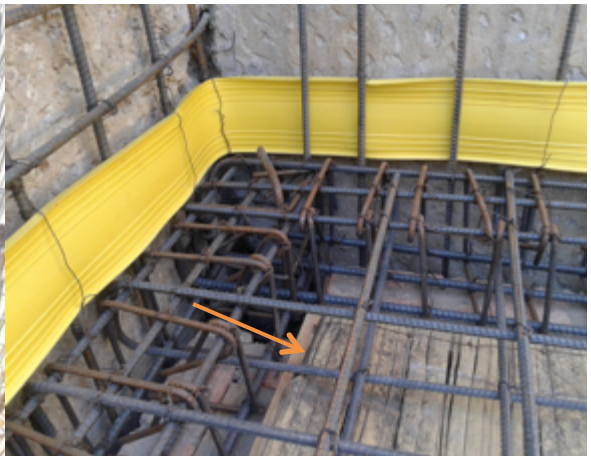
Ilustración 57. Proceso constructivo de sello hidráulico
