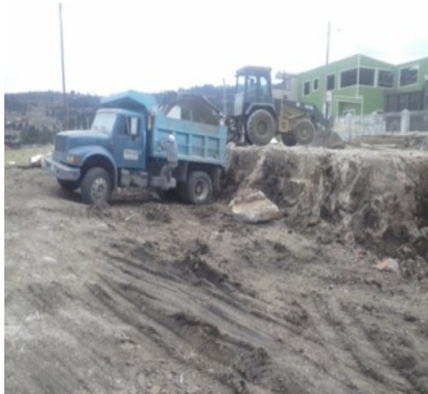
Ilustración 9. Excavaciones mecánicas de material orgánico
