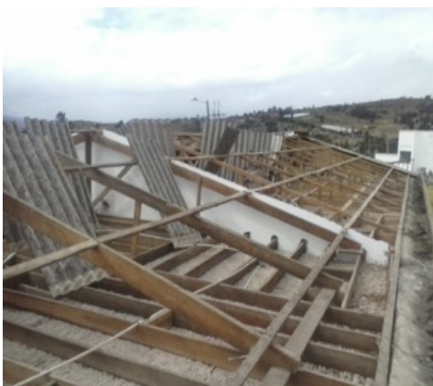
Ilustración 3. Retiro de cubierta ESE.
