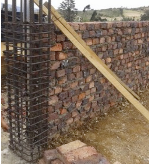
Ilustración 17. Instalación de refuerzo para columnas.
