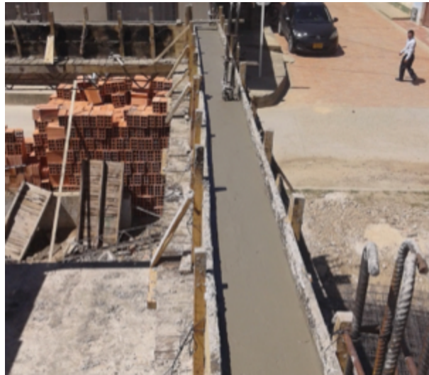
Ilustración 13. fundida de viga en concreto reforzado.
