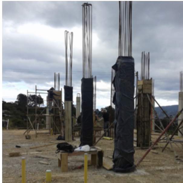
Ilustración 16. Columnas de concreto reforzado.
