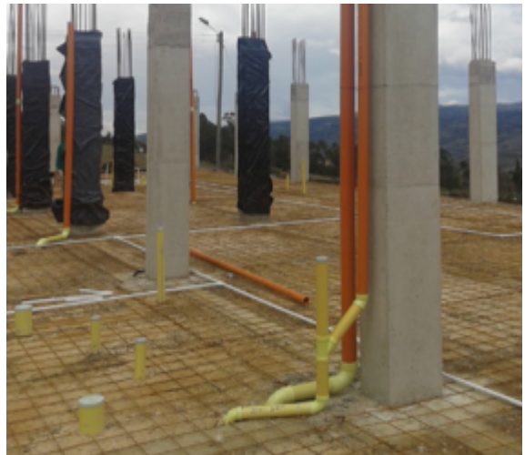
Ilustración 24. Proceso constructivo de tubería para bajantes
