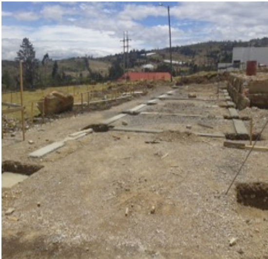
Ilustración 10. Excavaciones manuales para Zapatas.
