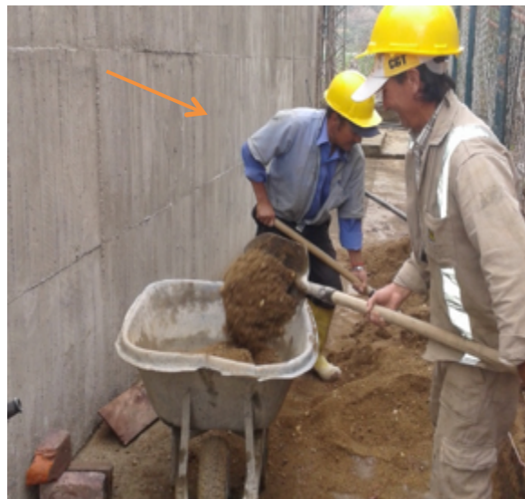
Ilustración 49. Retiro de material de filtro
