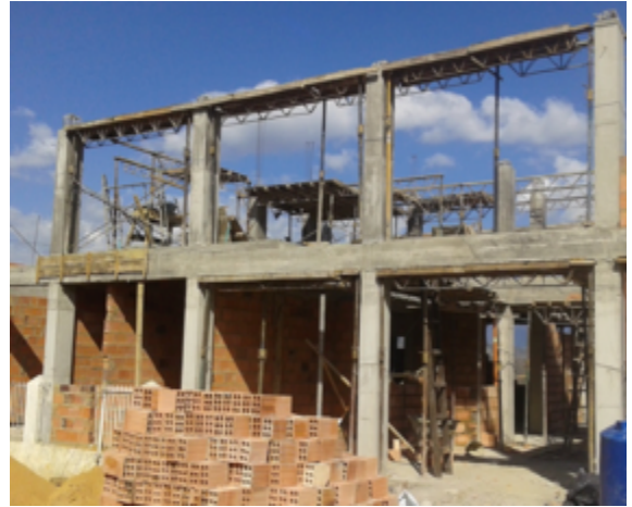
Ilustración 19. Proceso constructivo de sistema pórtico
