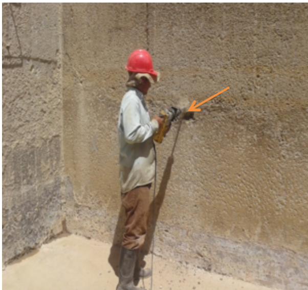
Ilustración 50. Perforaciones para anclajes
