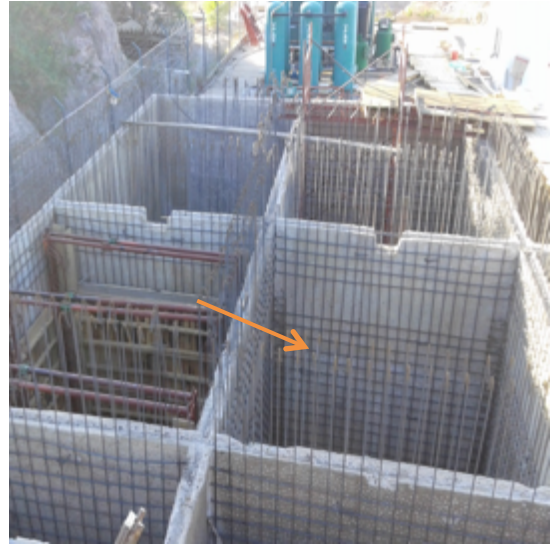
Ilustración 59. Refuerzo en módulos de tratamiento
