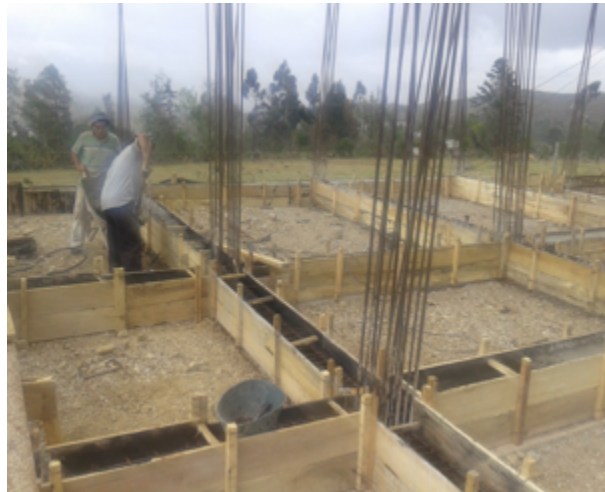
Ilustración 11. Fundida de vigas de cimentación.
