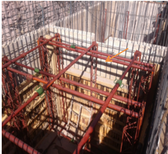
Ilustración 54. Proceso constructivo del reforzamiento
