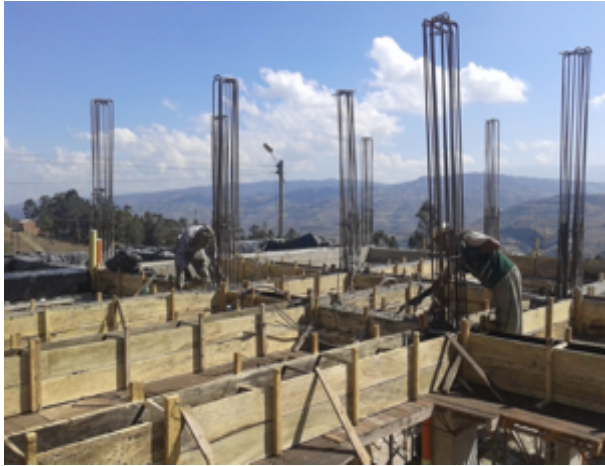
Ilustración 18. Proceso constructivo de vigas aéreas
