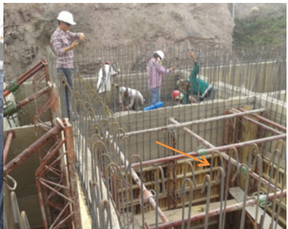
Ilustración 53. Adecuación de refuerzo para zona de floculación
