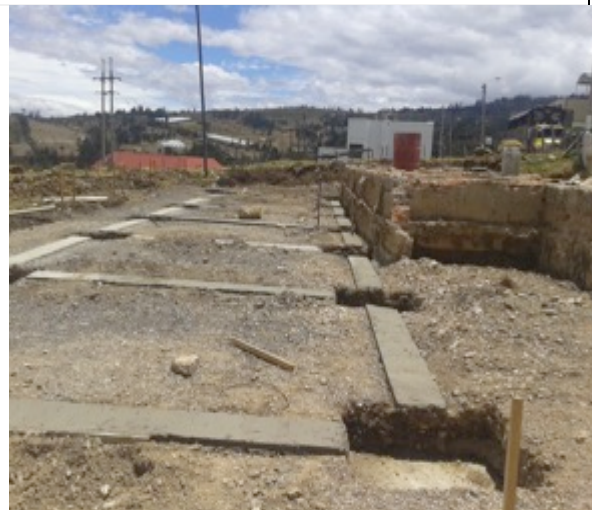
Ilustración 12. Solados en elementos para elementos de cimentación.
