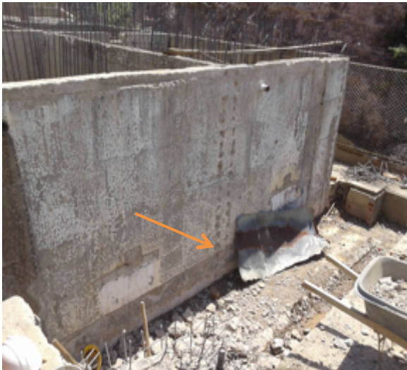
Ilustración 55. Demolición de placas en concreto
