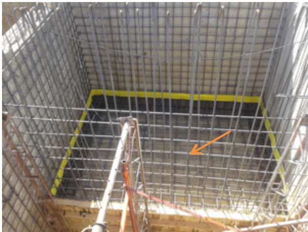
Ilustración 56. Instalación de cinta Sika
