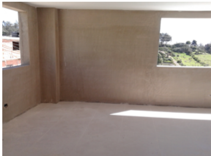
Ilustración 27. Instalación de enchapes de piso
