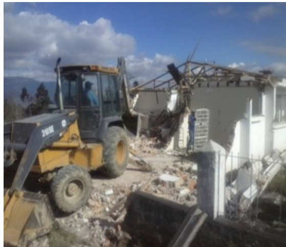
Ilustración 4. Demolición mecánica ESE.
