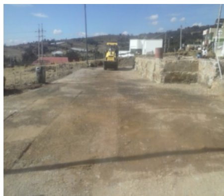
Ilustración 8. Compactación de material seleccionado.
