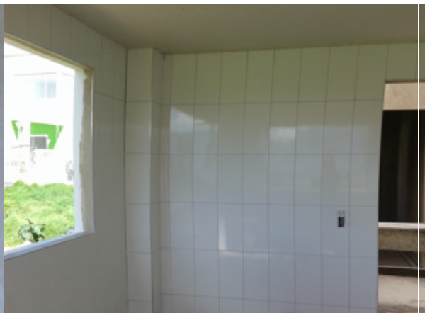
Ilustración 29. Suministro e instalación de enchapes de muro
