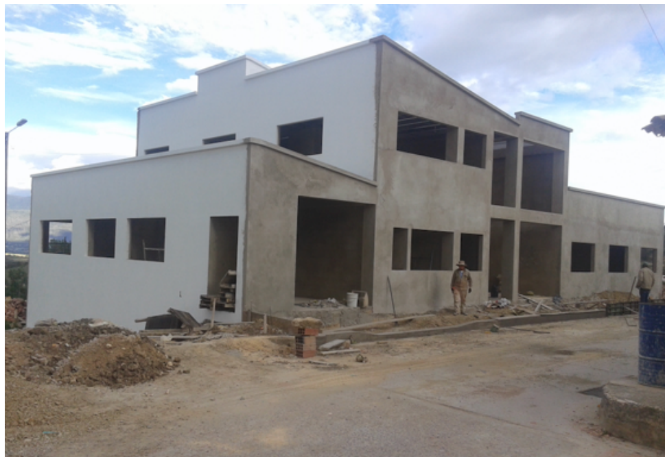
Ilustración 34. Instalación de graniplas en fachada
