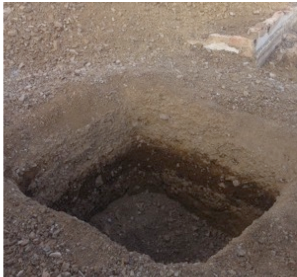
Ilustración 7. Excavaciones manuales para Zapatas
