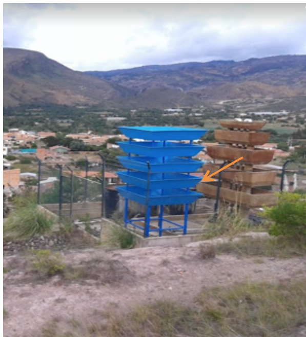
Ilustración 61. Módulos de aireación.
