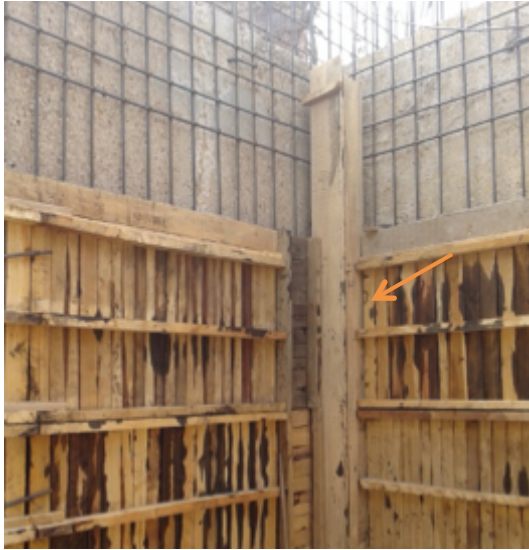
Ilustración 58. Proceso constructivo del reforzamiento.
