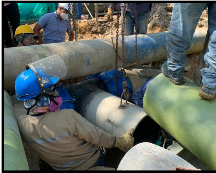
Figura 18. Empalme tubería de 18” Obra Ampliación PTAP “La Colina”. Autor.
