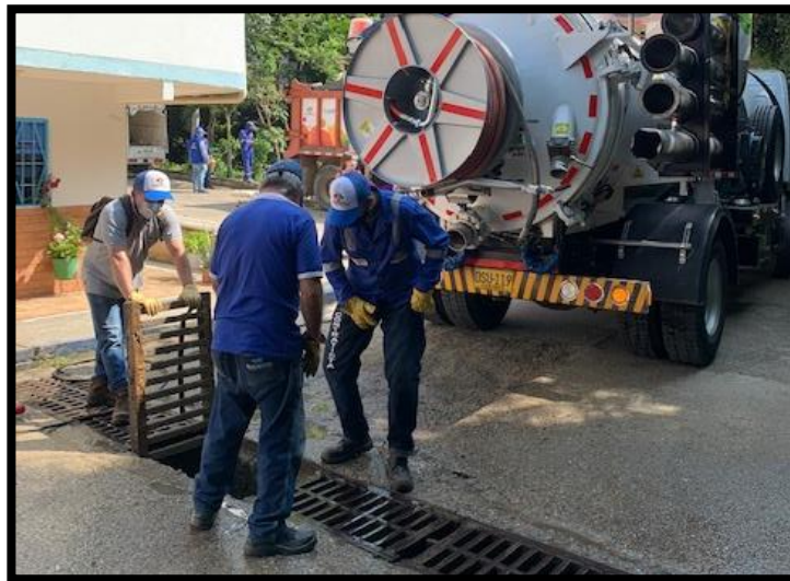
Figura 6. Mantenimiento preventivo y correctivo del Sistema de Alcantarillado, Barrio San Juan. Autor.
