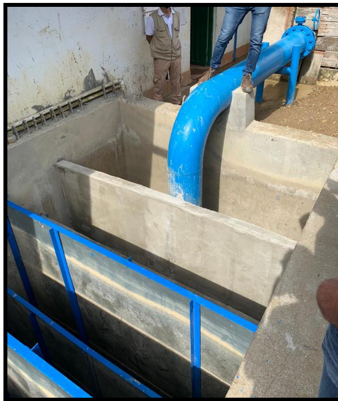
Figura 15. Visita obra Ampliación PTAP “La Colina”. Autor.
