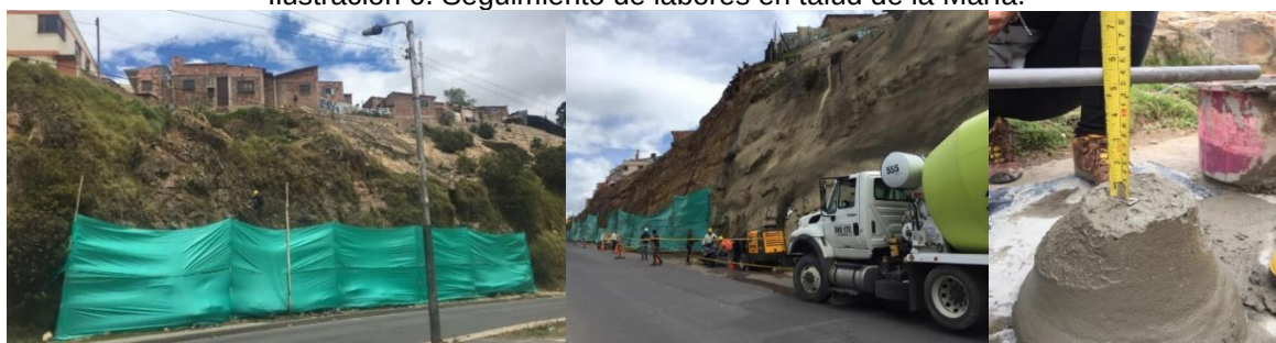
Ilustración 6. Seguimiento de labores en talud de la María.
