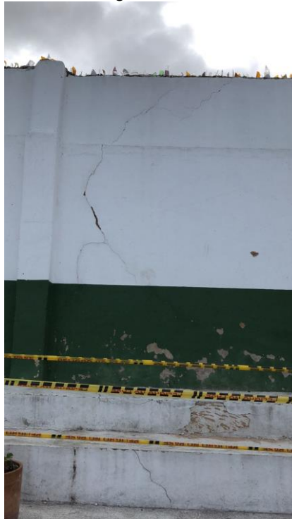
Ilustración 5. Cerramiento del Colegio Carlos Arturo Torres INEM-Sede Piloto.
