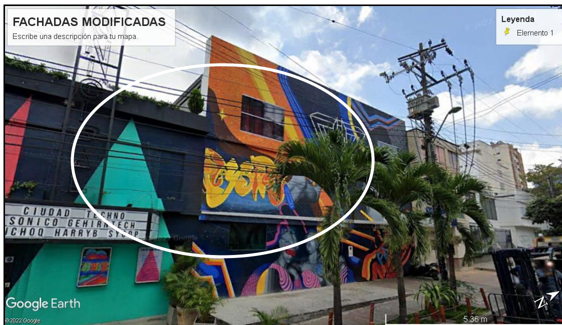
Figura 34. Fachada modificada 2022, antiguo sector de vivienda.
