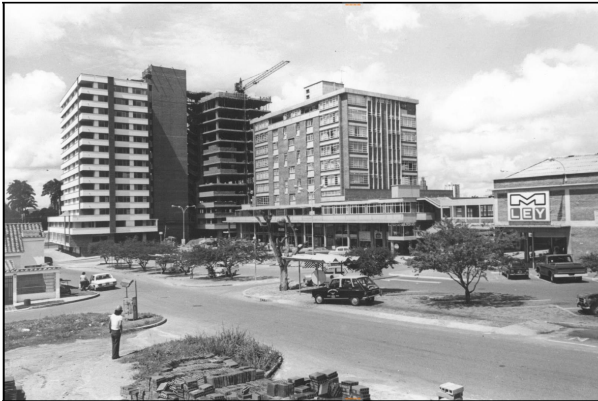
Figura 21. Centros comerciales Cabecera I etapa y II Etapa
