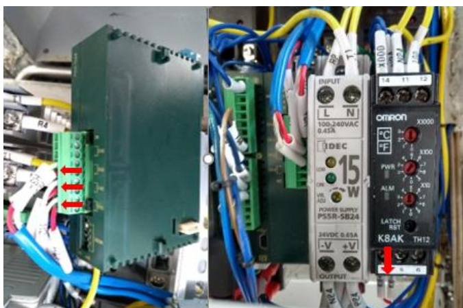
Figura 24. Punto de llegada de la señal de las termocuplas.
