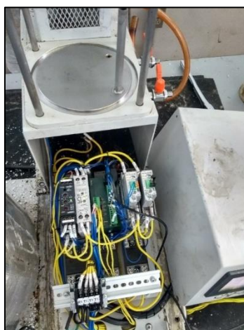
Figura 20. Instrumentación del pirolizador.
