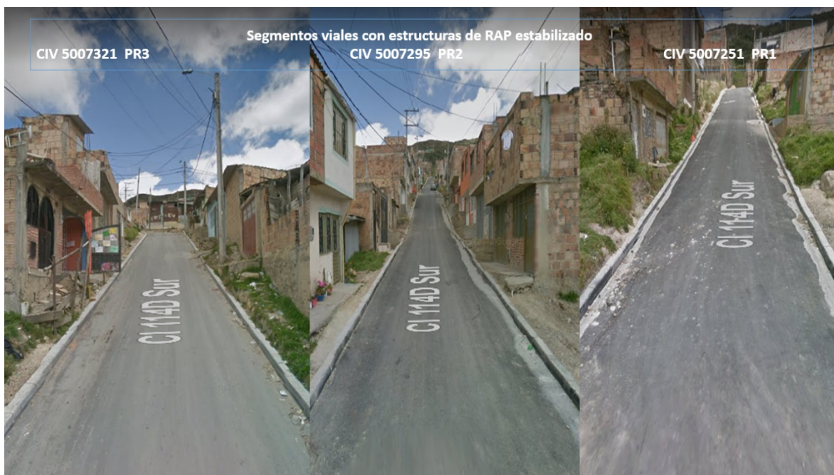
Imagen 26 Vías evaluadas con estructura de RAP estabilizado. Fuente: Autor.
