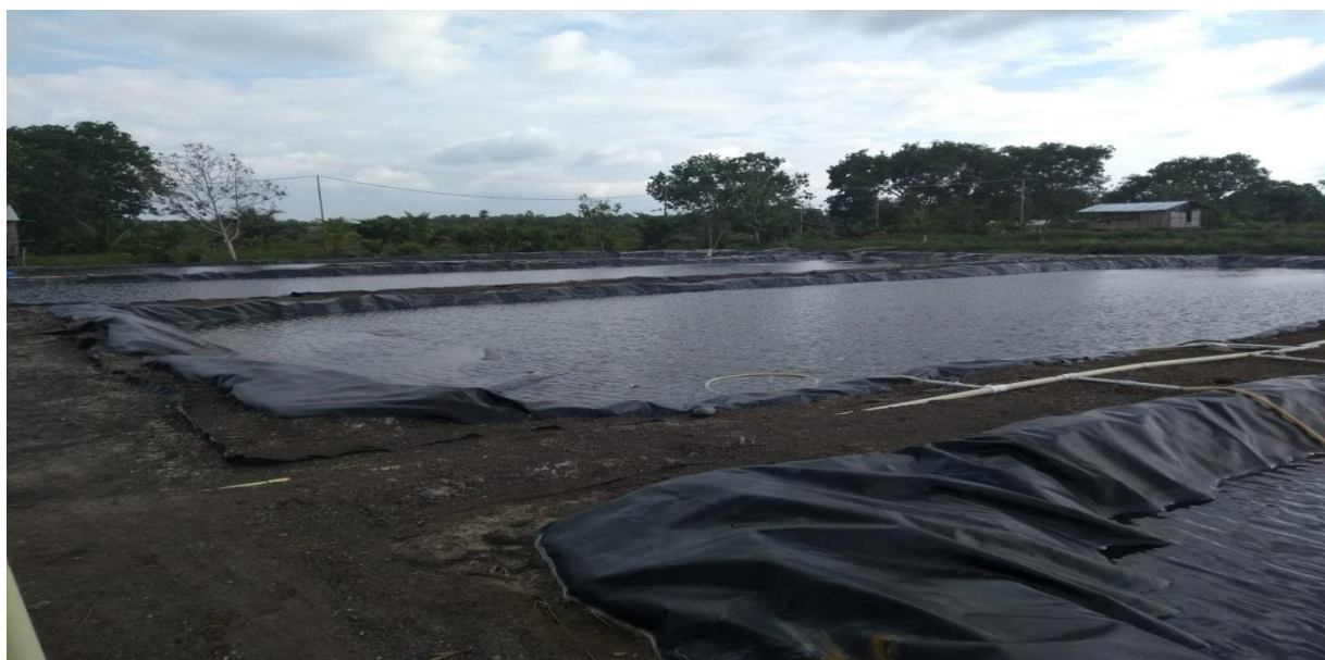
Figura 1 Estanques en geomembrana Agromar Pacífico SAS
