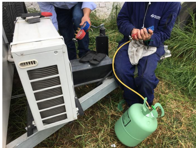
Fig#6: Mantenimiento aires acondicionados estación Móvil de Bomberos.
