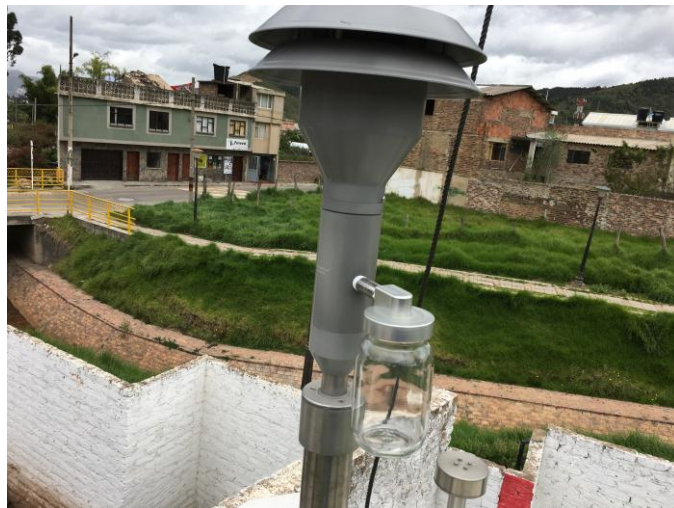
Fig#2: Cabezal estación Bomberos.
