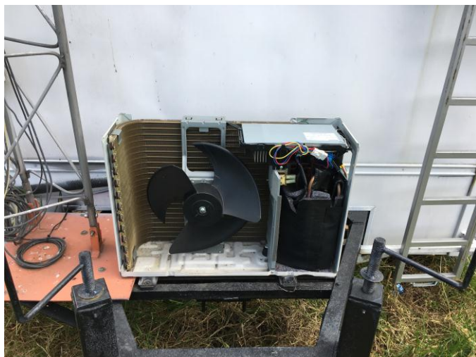
Fig#4: Mantenimiento aires acondicionados estación Paipa.
