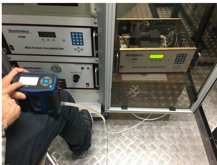
Fig. #25: Calibración equipo Multi-gas.
