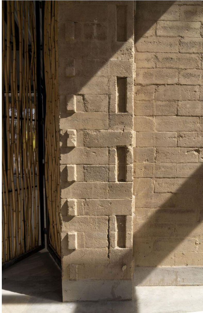
Figura 38. Sistema constructivo Centro Comunitario Cuexcomate
