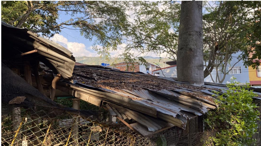
Figura 4. Cubierta sede el adulto mayor Rocío del Amanecer Zapamanga Primera Etapa
