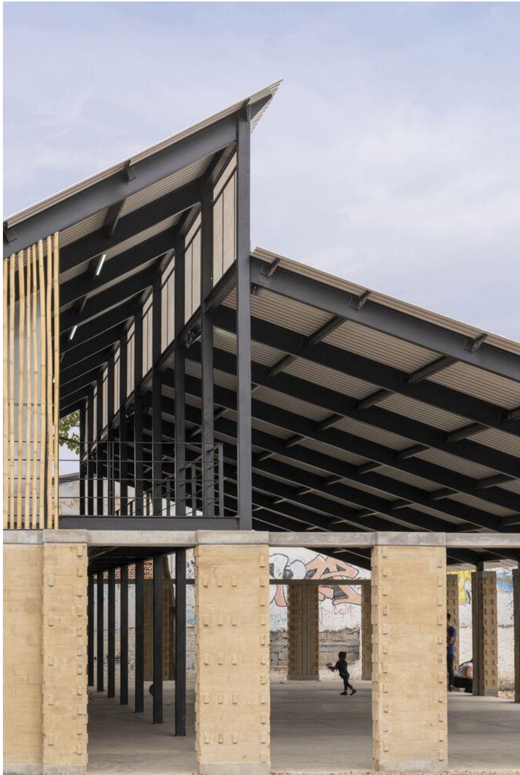
Figura 34. Sistema estructural Centro Comunitario Cuexcomate 1
