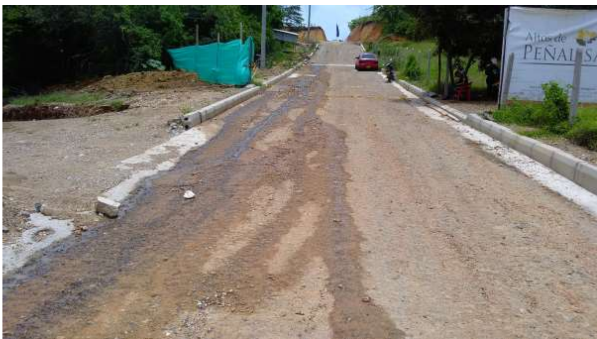
Ilustración 3. Registro de visita a inspección 2. Fuente: Elaboración propia.
