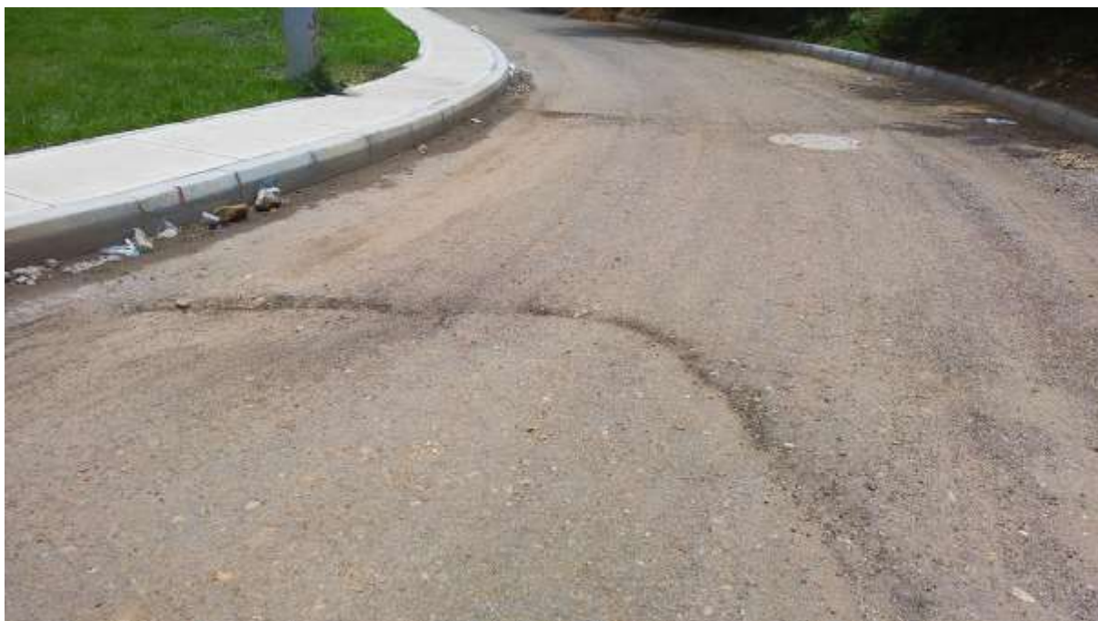
Ilustración 4. Registro de visita a inspección 2. Fuente: Elaboración propia.
