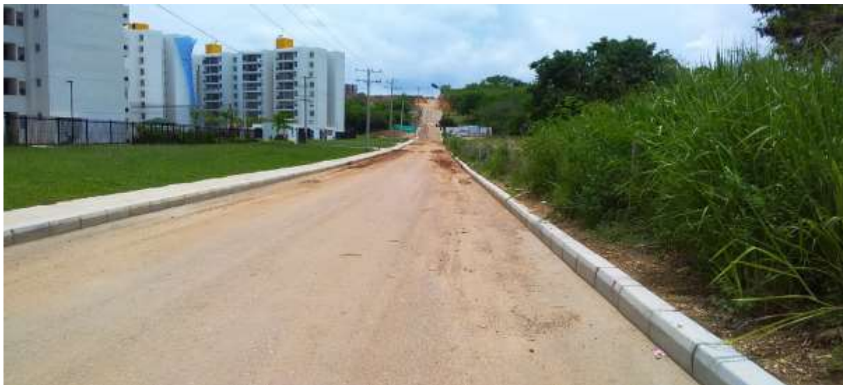
Ilustración 2. Registro de visita a inspección 1. Fuente: Elaboración propia.
